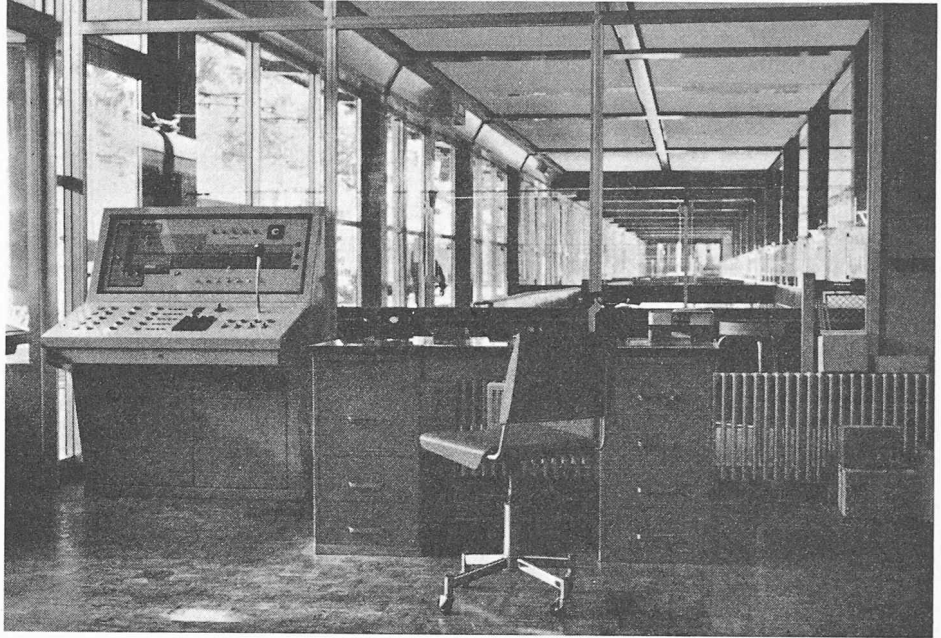
Bild 11. Vorstandsbüro mit Schaltpult für die Stationsbeleuchtung und die Personenleitanlage
