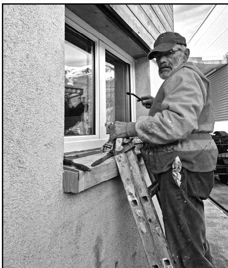
Malermeister Aschi Mürger bei der Arbeitsvorbereitung (tb)
