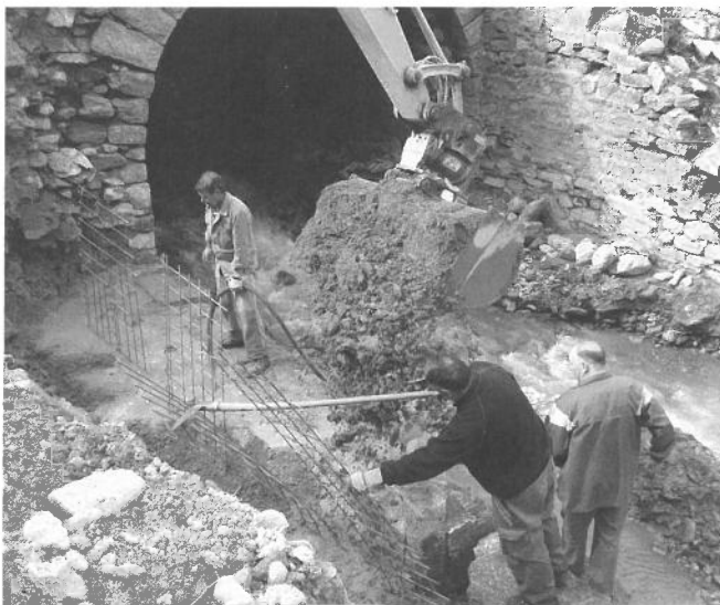
Beim Bachdurchlass wird das Fundament betoniert. Bétonnage des fondations près de l'écoulement d'eau.
