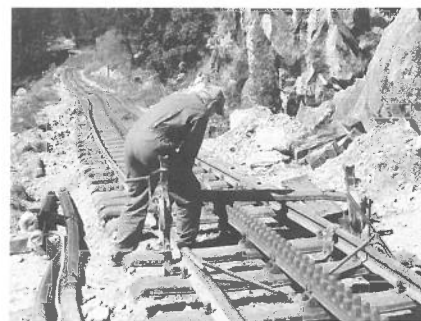
Gleishebung für Schwellenwechsel. Relevage de la voie pour changement de traverse.
