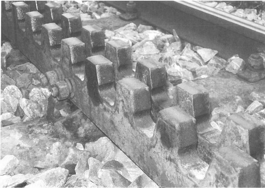
Die Sprühdüsen benetzen die bergseitigen Flanken sowie die Köpfe der Zahnstangen-Zähne.
