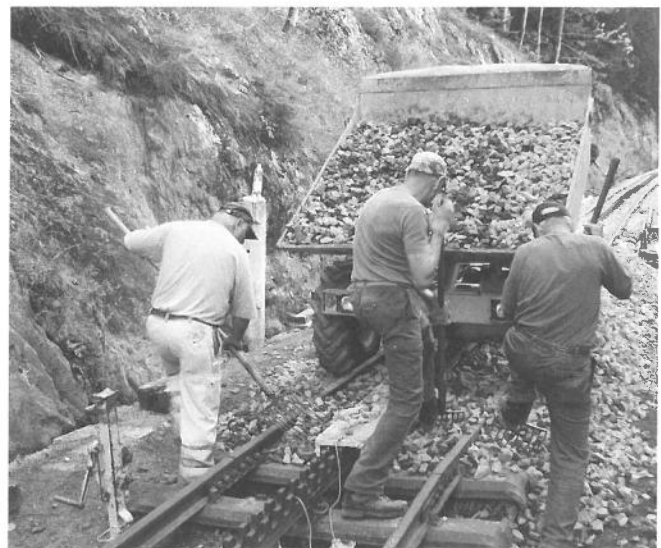
Das Gleis wird mit dem Dumper eingeschottert. Ballastage avec le dumper.
