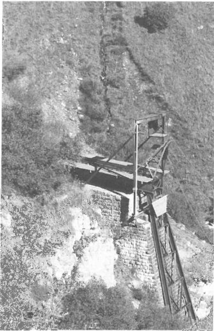
Oberer Brückenteil in Winterstellung. Élément amont en position d'hiver.
