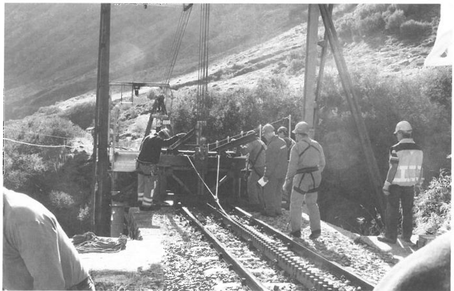
Rückzug des oberen Brückenteils. Repli de l'élément amont.
