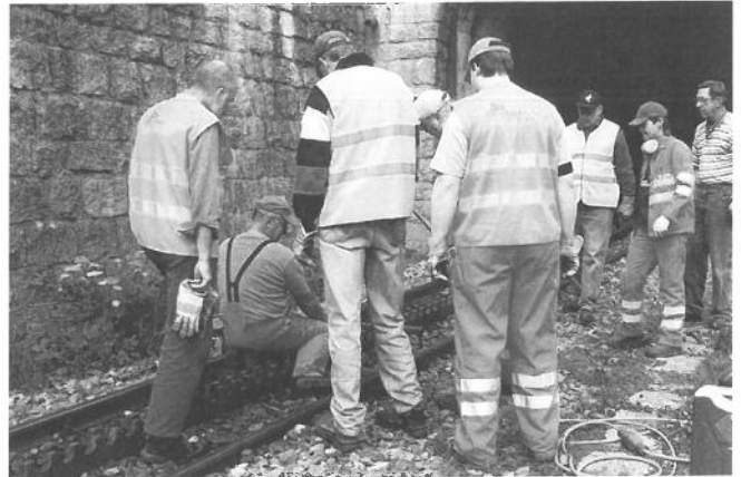
Einweisung durch Dieter Koesling an der neuen Messlehre für die Zahnstangenhöhe.
