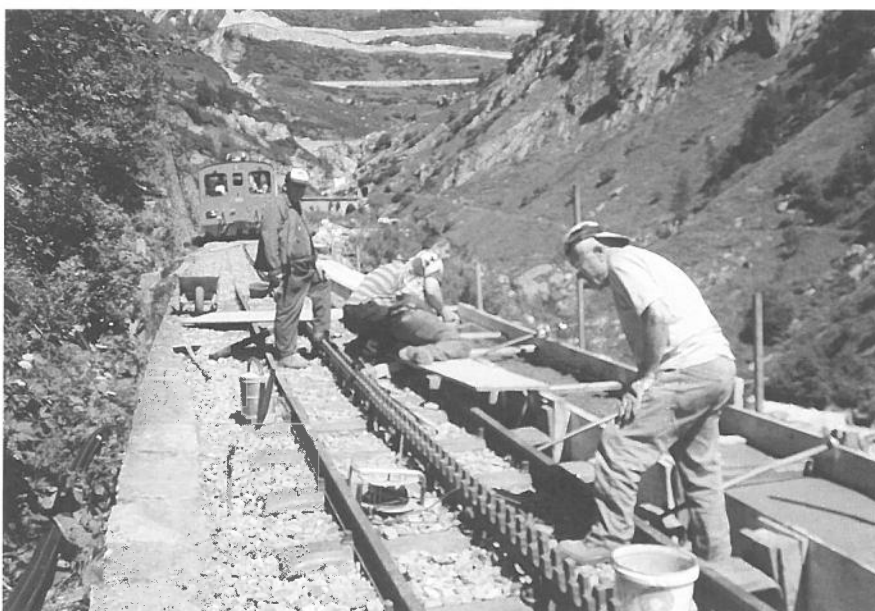
Betonniieren der Brüstung der Brücke unterhalb des Rhoneviadukts. Bétonnage du parapet du pont de la voie après celui du Rhône.
