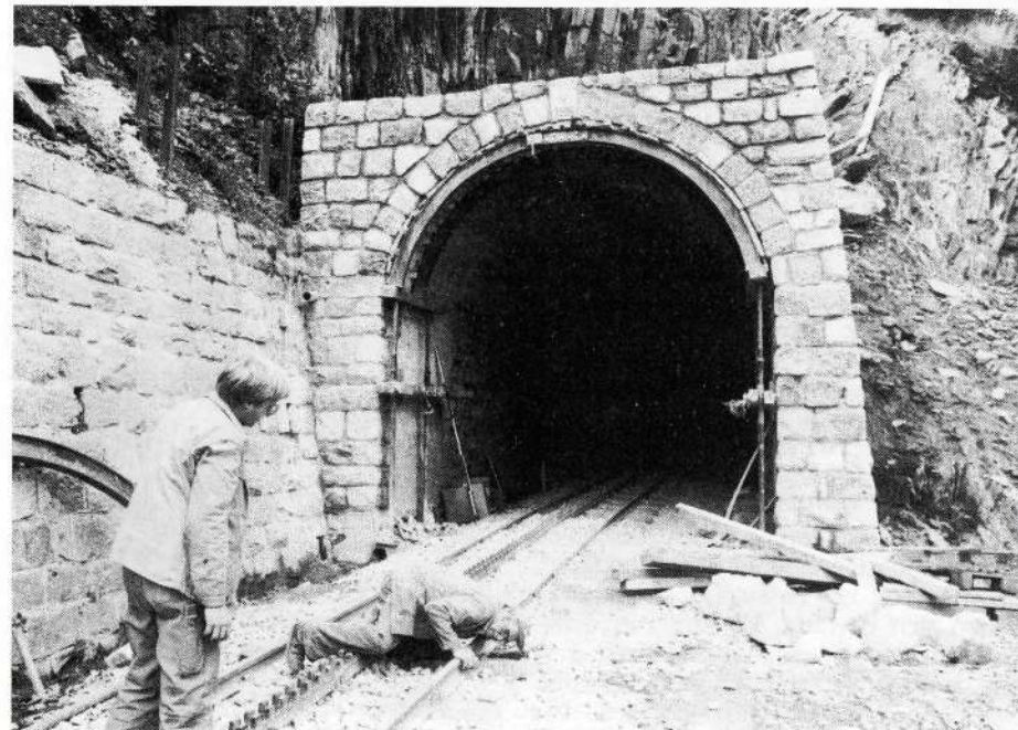
Das talseitige Portal von Tunnel III ist durch Ausbilder der schweizerischen Maurerschule mit Bruchstein verkleidet worden. Im Vordergrund sind die Gleisbauer am Werk.
