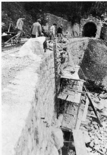
Die betonierten Stützmauern vor dem Tunnel III wurden fachmännisch mit Bruchstein verkleidet.
