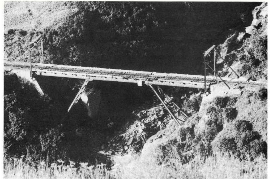
Die Steffenbachbrücke ist zu Beginn der Bausaison in Betriebsstellung gebracht worden, nachdem zuvor die nötigen Reparaturarbeiten erfolgreich abgeschlossen werden konnten.
