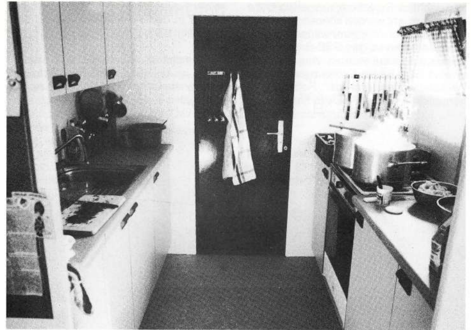
Die Küche des Speisewagens: modern und alles da
