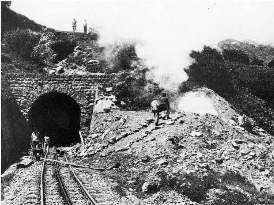
Grosseinsatz am Tunnel I
