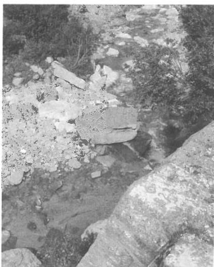
Der Felsblock in der Furkareuss nach der Beschädigung des Gleises
