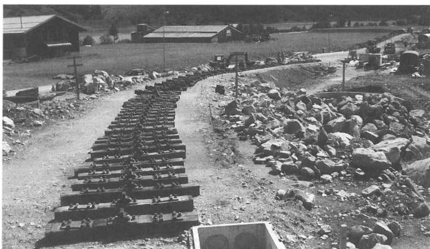
Schwellen für die Einfahrt Oberwald (Foto: Peter Studer, September 2009) Traverses pour l'entrée en gare d'Oberwald (photo: Peter Studer, septembre 2009)
