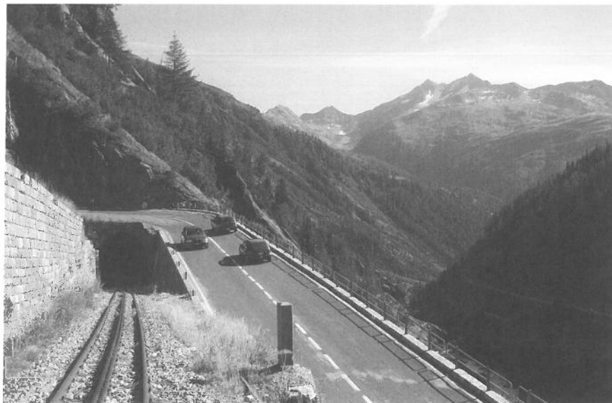
Kehrtunnel-Eingang, Bergseite Tunnel hélicoïdal, entrée amont
