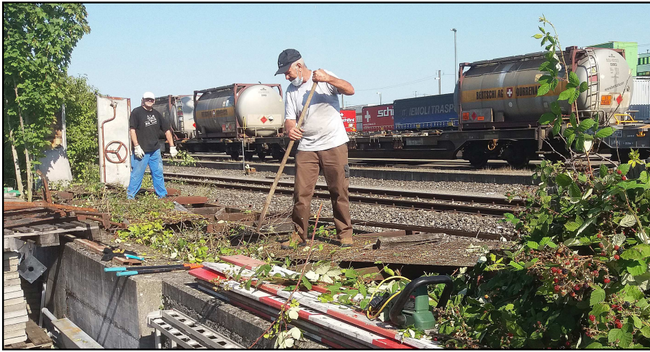
Freilegen des überwucherten Chassis am 30.7.2020
