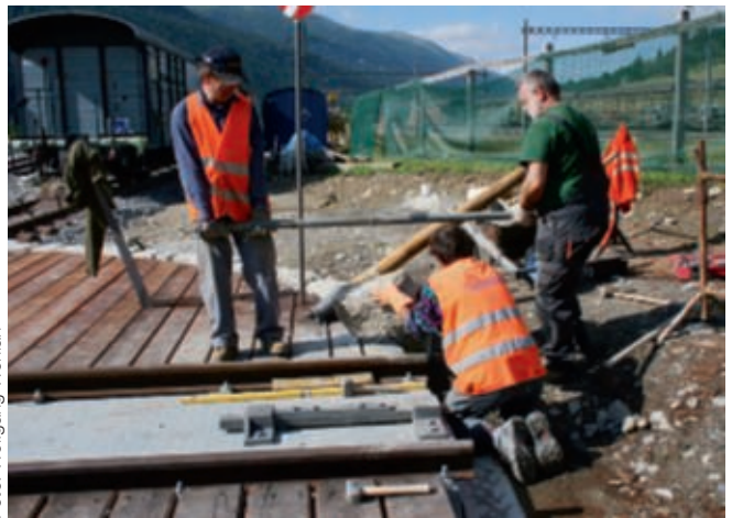
Einsetzen eines Steinquaders Mise en place d'un moellon
