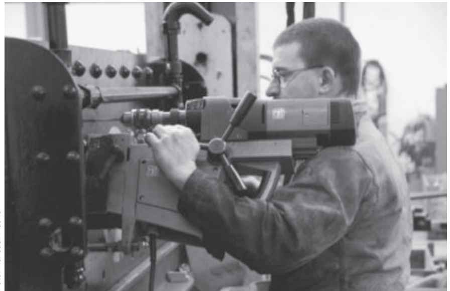
Michael Bühler beim Vorbohren für eine Rohrdurchführung. Michael Bühler lors du préperçage d'un conduit.
