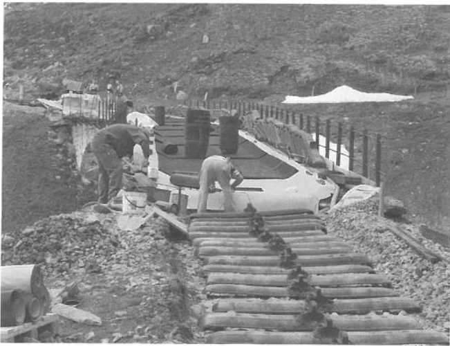
Gleisbau beim Steinstafel-Viadukt. Construction de la voie au viaduc de Steinstafel.
