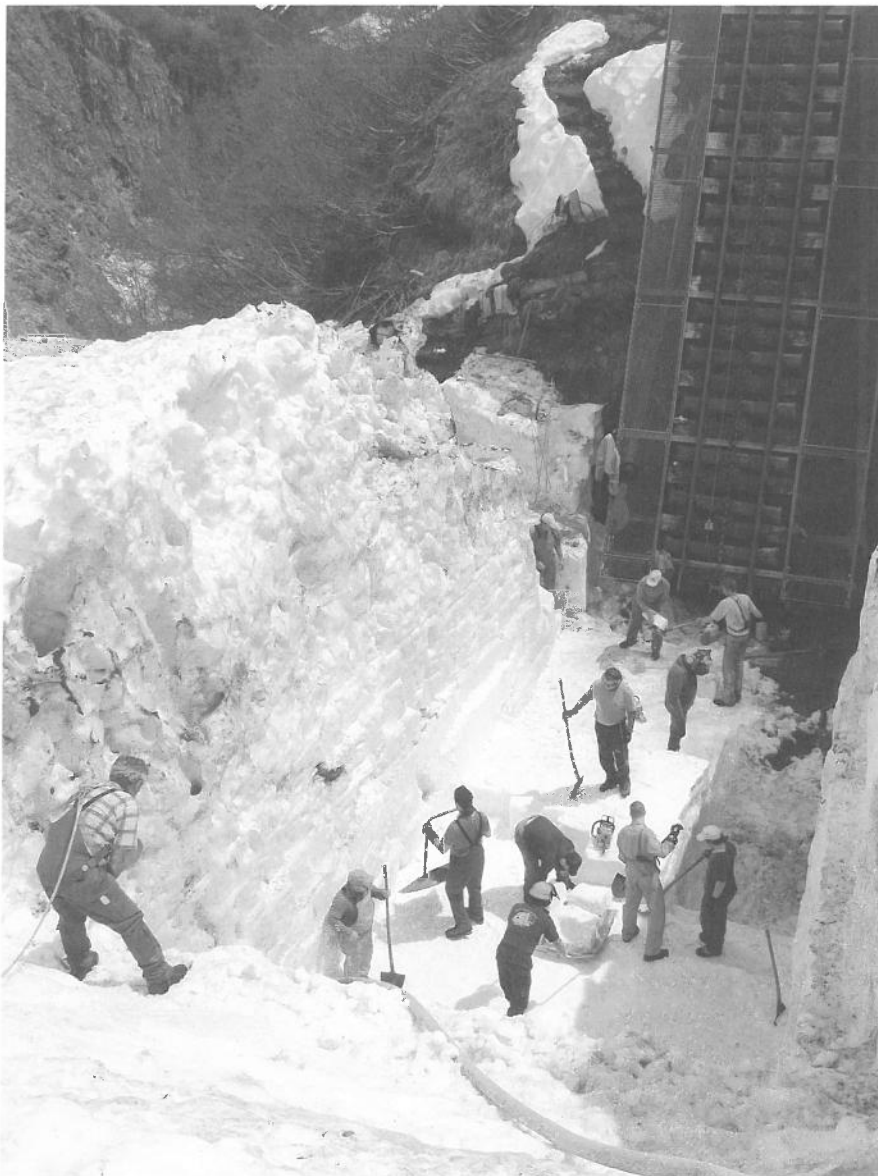
Am Grund angelangt. Nach fast zwei Wochen Arbeit ist der Brückenmittelteil frei. Arrivée au fond. Après presque deux semaines de travail la partie médiane du pont est dégagée.
