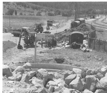
Baustelle Oberwald mit Drehscheibe Chantier Oberwald avec plaque tournante.
