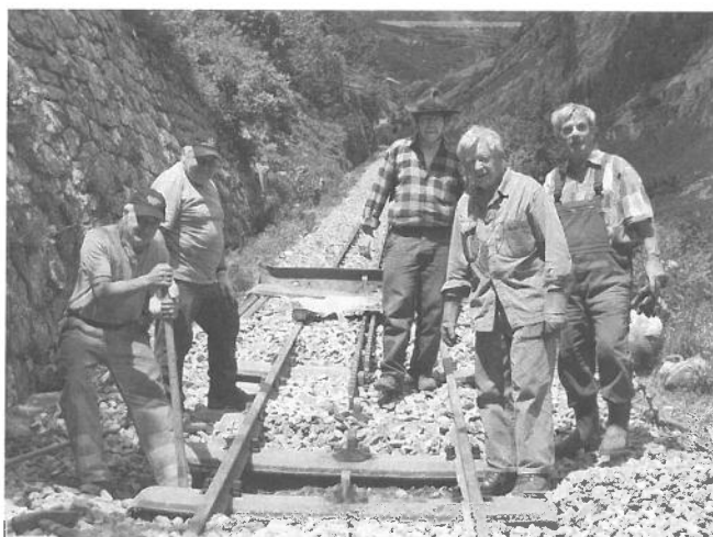
Arbeitsgruppe «Felssturz». Groupe de travail «Chute de Pierre».
