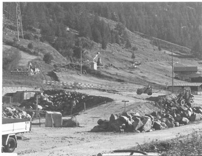
Der in Oberwald geschüttete Damm zur Kantonsstrasse. Le remblai élevé vers la route cantonale à Oberwald.
