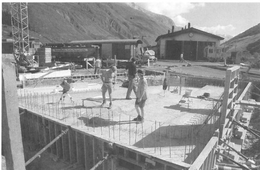
Baustelle Remise Realp am 19. August. Chantier remise Realp le 19 août.
