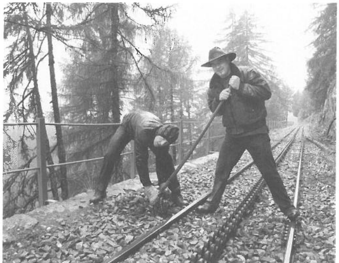
Schotter entfernen an der Strecke Gletsch–Oberwald mit dem System You Go.
