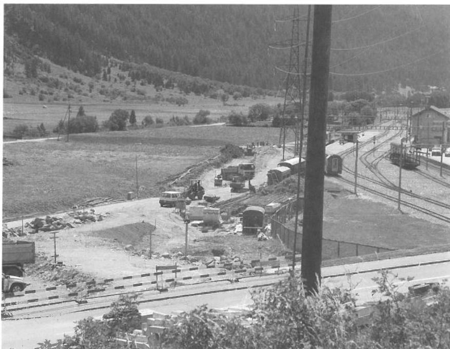
DFB Baustelle neben dem Bahnhof der MGB in Oberwald. Chantier DFB à côté de la gare du MGB.
