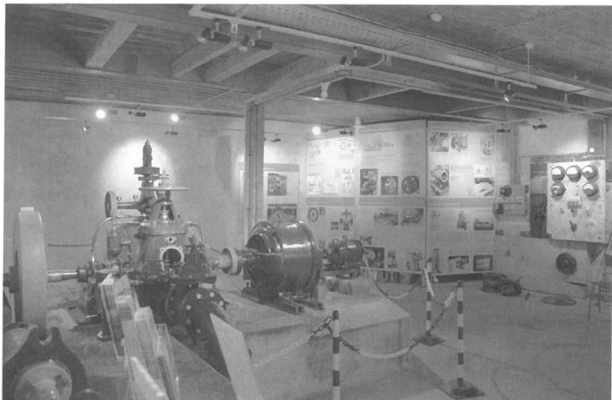
Turbinen-Generator-Gruppe im Blauen Haus. Groupe turbine-générateur dans la Maison bleue.
