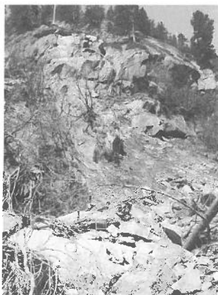
Felssturz bei Kilometer 43.950.
