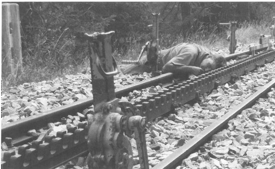
Richtarbeiten am Zahnstangengleis. Travaux de réglage de la voie à crémaillère.
