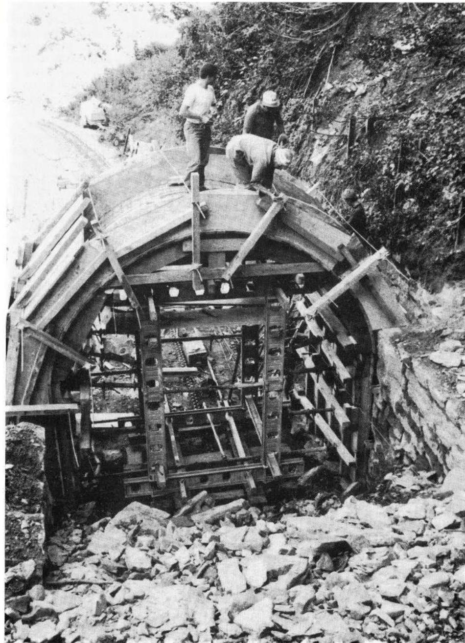
Das durchdachte Lehrgerüst, kurz vor der Einbringung des sichernden Betons, einmal von oben gesehen.
