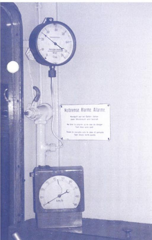
Blick in den Führerstand des CFm 21 mit Druckmesser der Vakuumbremse, Notbremse und Geschwindigkeitsmesser.
