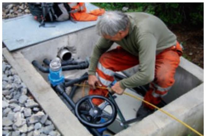
Einziehen von total 270 m 16-adriges Kabel für die Sprinklersteuerung von Schacht zu Schacht / Tirage d'un regard à l'autre d'un total de 270 m de câble à 16 brins pour la commande de l'arrosage
