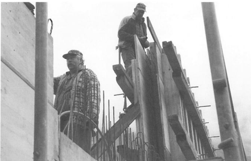
An Schalung und Armierung für das Obergeschoss wird gearbeitet.
