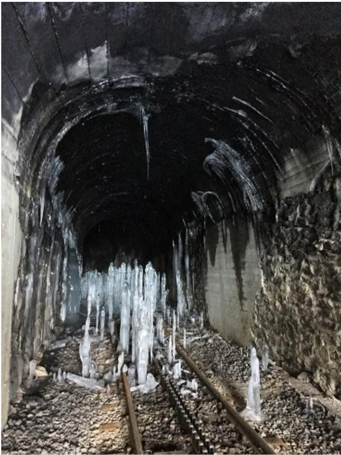
Stetiges Tropfwasser ca. 10 m vom talseitigen Portal des Tunnels 3 führten zu Vereisungen auf einer Länge von ca. 5 m.
