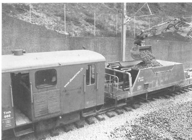
Tmh 986 beim Schotterladen Tmh 986 lors du chargement de ballast (photo: Adolf Odermatt)
