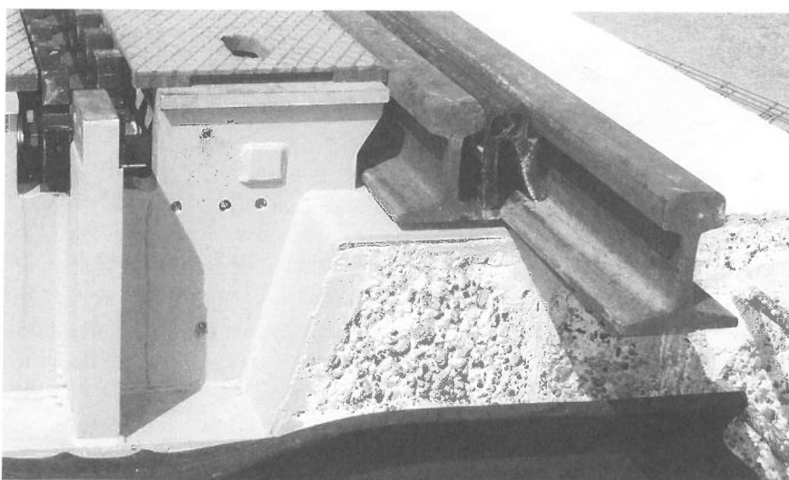
Bergseitige Frontansicht mit eingebauter Zahnstange, rutschfesten Abdeckblechen, Spurrillendichtung zwischen Fahr- und Doppelschiene (Fotos: Bänz Bangerter) Vue frontale de l'extrémité amont avec la crémaillère installée, plaques de couverture en tôle antiglisse, inserts en gomme entre rail et contre-rail (photos: Bänz Bangerter)
