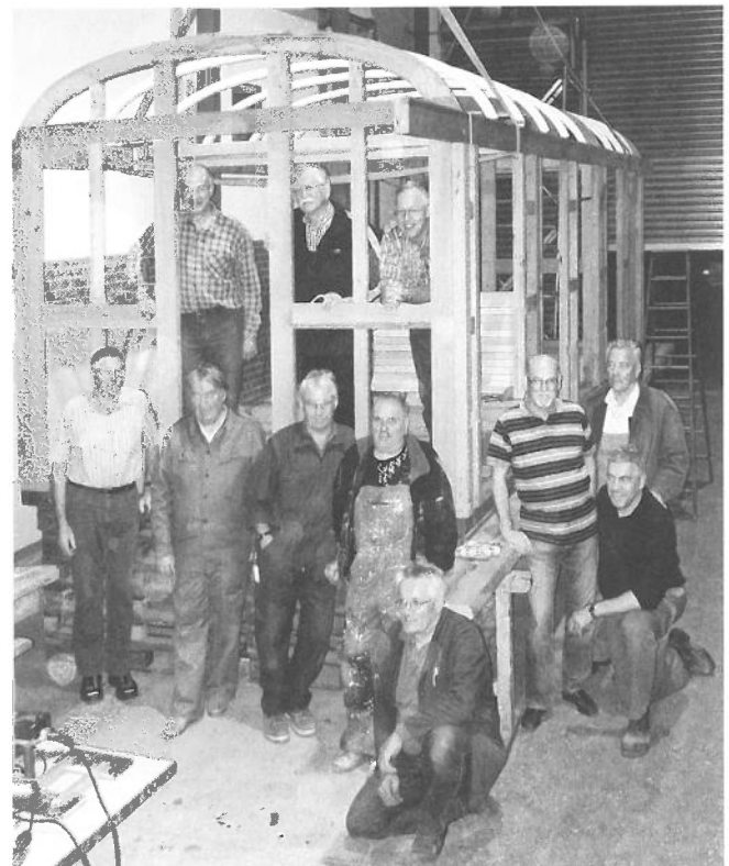
Der Wagenkasten des B 2206 als Probe-Aufbau La construction d'essai de la caisse du B 2206
