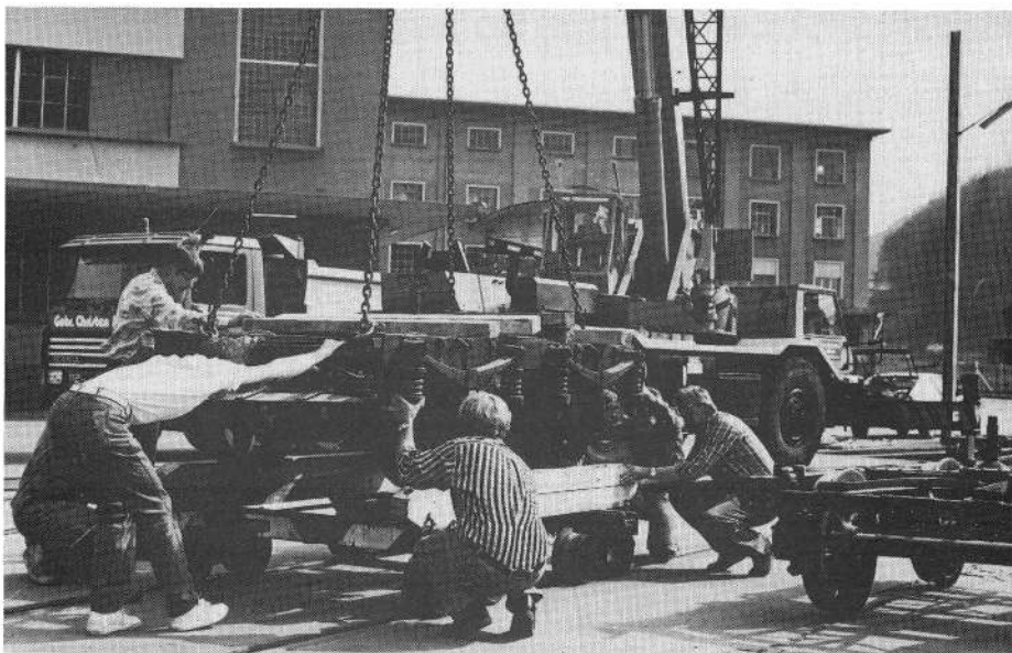
Abiad der Drehgestelle ex BVZ auf Normalspurdiploir im Areal der Papierfabrik Deisswil Foto: Archiv DFB
