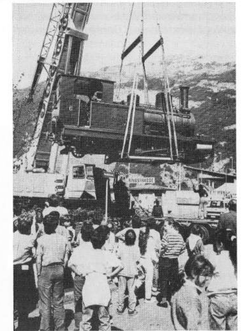
Die HG 2/3 «Weisshorn» wird unter der Anteilnahme der Schulkinder des Herold-Schulhauses in Chur auf den Tiefganganhänger gehievt.
