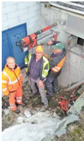
Kernbohrung für das Sicherheitsventil der Vorheizanlage
