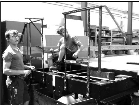
Probemontage der Plattformgeländer am Wagenchassis
