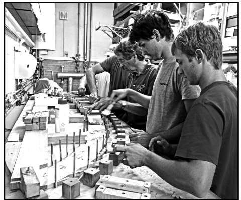
Teamarbeit beim Verleimen der Einzelbrettchen zum Dachbogen
