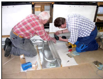
Einbau einer Dampfheizung
