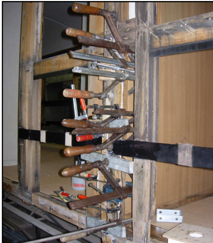
Sanierung von Holzträgern
