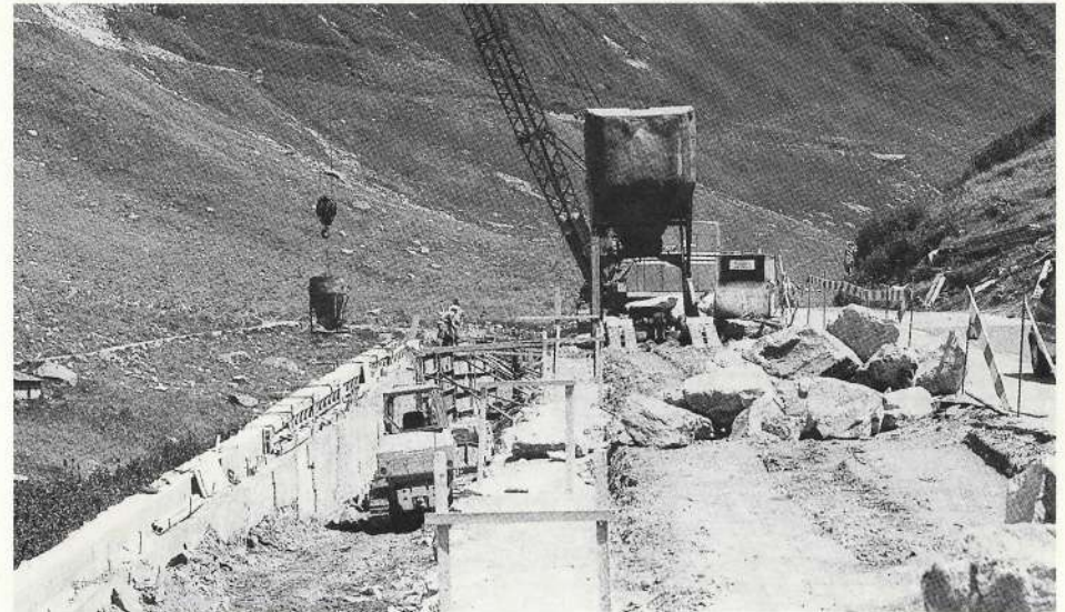
Die Arbeiten in Muttbach im Bereich Strasse.
