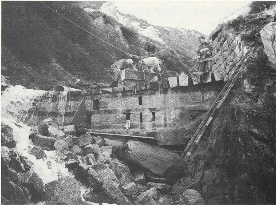
Im Kampf gegen das Wasser im Steffenbachtobel. Die Unberechenbarkeit des Wassers bereitet oft Sorgen und erfordert laufende Unterhaltsarbeiten.
