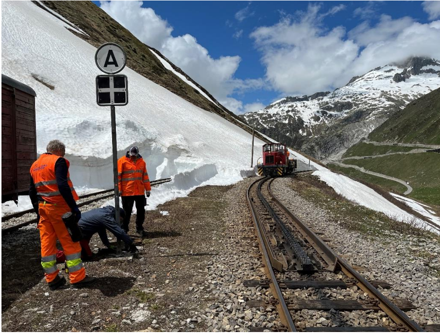
Beat Mühlemann, Arno Rudolf und Christian Weiller montieren das Zahnstangensignal der Station Muttbach-Belvédère.
