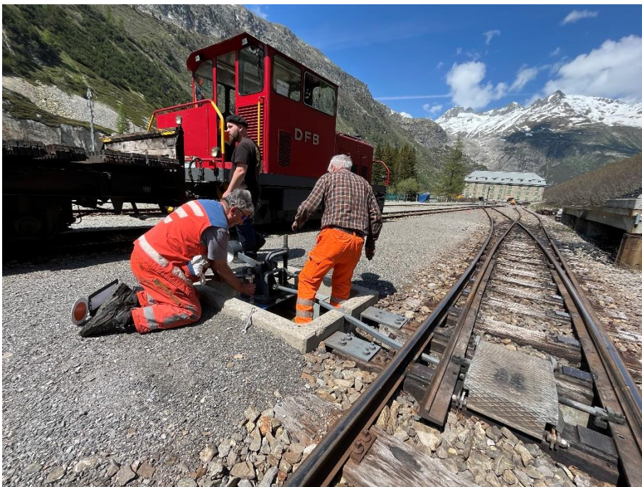
Guido Tresp und Toni Hobi montieren die Stellvorrichtung der Weiche 15 der Station Gletsch. Der Lokführer Nicolas Darioli wartet auf den nächsten Fahrbefehl.
