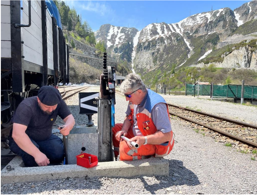
Guido Tresp und Nicolas Darioli montieren die Stellvorrichtung der Weiche 16 der Station Gletsch.
