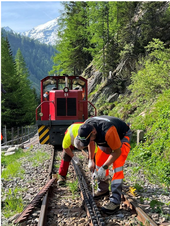
Martin Wieland und Beat Suter lösen die Verschraubungen der defekten Zahnstange bei km 43.950.
