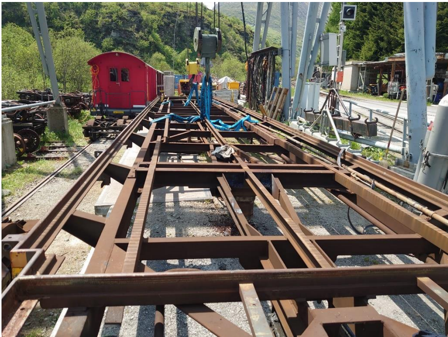
Im Gleis 6 des Bahnhofs Realp wird das Chassis eines Wagens des ehemaligen Autozuges am Oberalppass zerlegt. Bild: Ruedi Schwarz.
