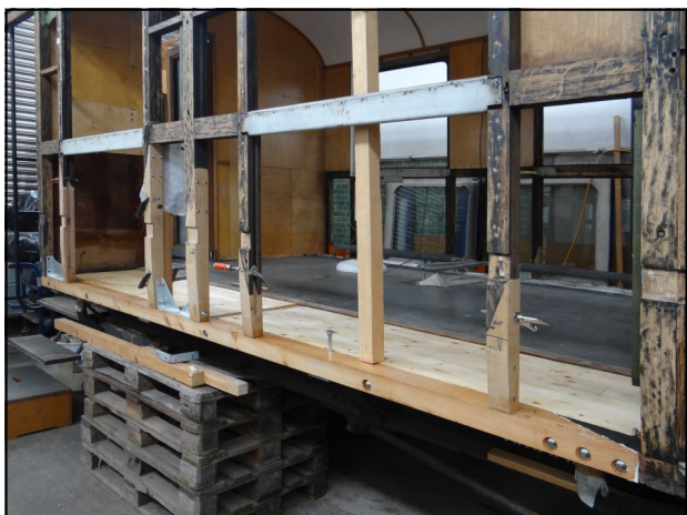
Ersetzter Bereich des Bodenbalkens und des Wagenbodens
