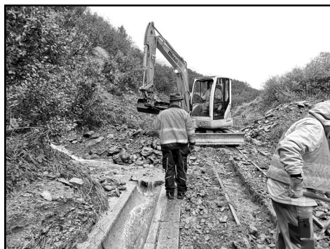
Aufwändige Baustelle, um das Gleis wieder freizulegen
