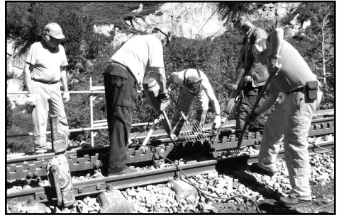
Gleisarbeit ist Schwerarbeit
