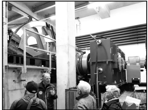
*Zwei Motoren mit je 1'500 PS ziehen die Gondeln sicher auf den Berg*
