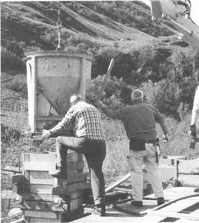
Betonieren der Pfeiler für die Bockkrane.
