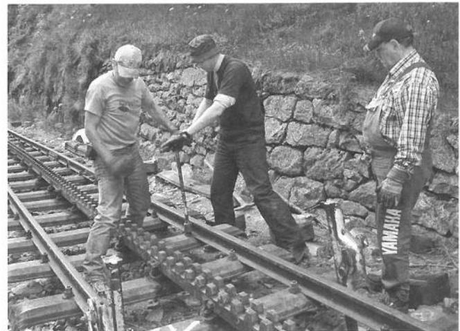
*Austausch defekter Stahlschwellen.
