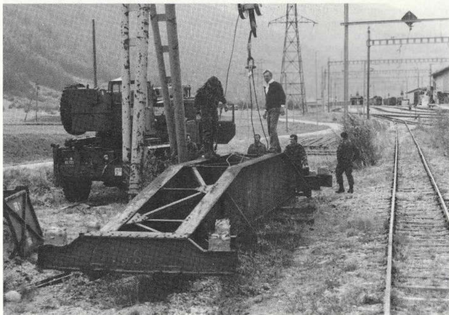
La plaque tournante à Oberwald lors de la préparation du transport pour Gletsch
