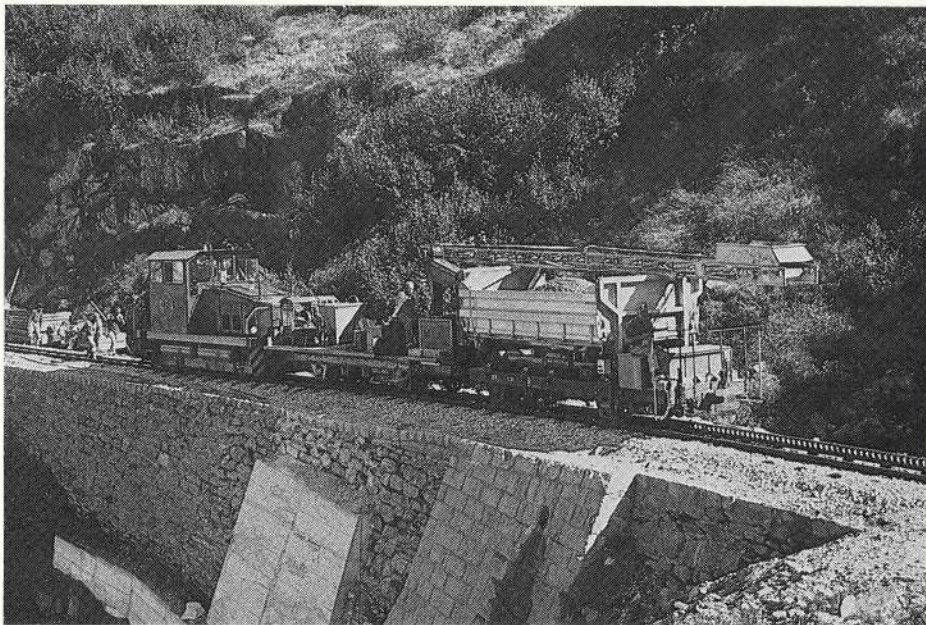
Der Bauzug auf der Fahrt zum Tunnel 1, wo Beton benötigt wird.
