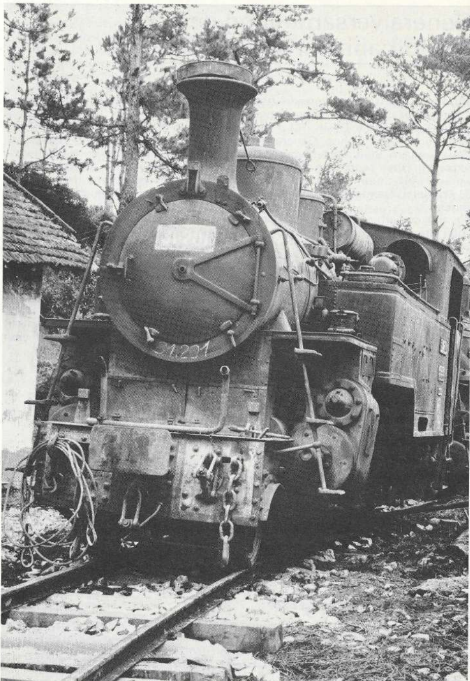
Lokomotive FO1, bereit für den Verlad auf den Tiefgangwagen
