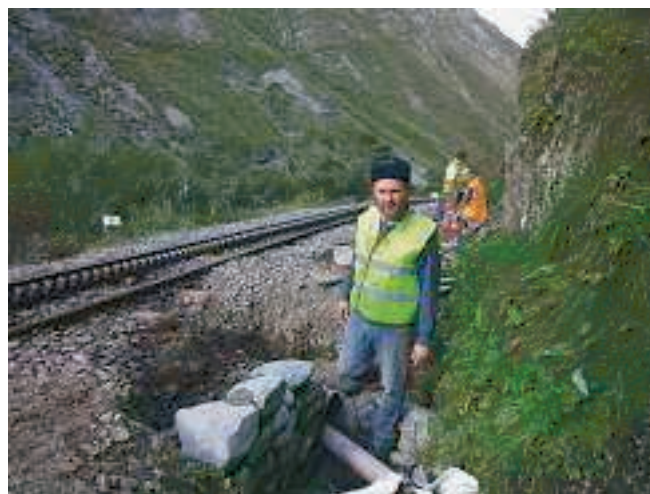
Bachdurchlass km 57,1 / Ponceau au PK 57,1
