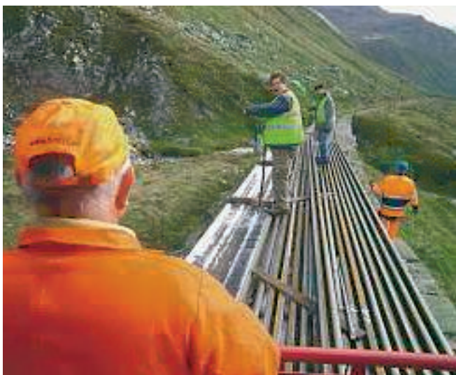
Schienenablad vor Furka / Déchargement de rails avant la Furka
