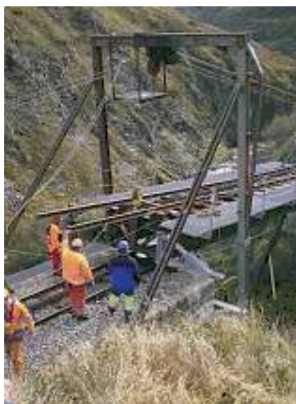
Beginn des Rückzugs des oberen Brückenteils. Die Brücke gleitet auf den eingefetteten Bahnschienen. / Début du repli de l'élément amont du pont. Le pont glisse sur les rails graissés.
