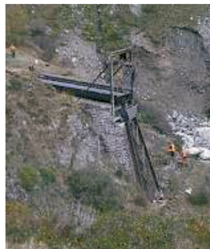
Oberer Brückenteil in Winterstellung. / Partie amont en position d'hiver.
