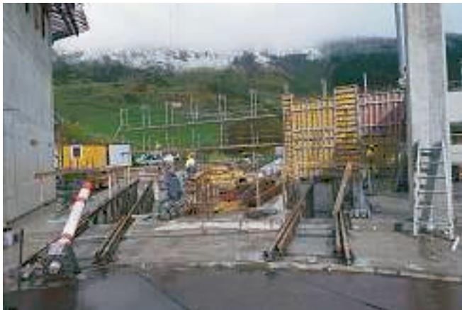
Neubau Gleis 82–83 / Construction voies 82–83
