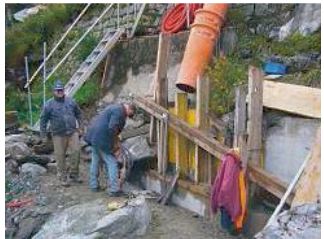
Unterfangung der Stützmauern / Sous-œuvre des murs de soutènement
