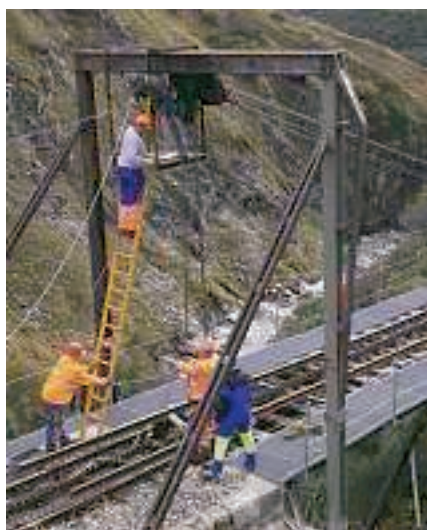
Das Einfädeln der zwei Drahtseile nimmt immer ziemlich viel Zeit in Anspruch. Die beiden Monteure sind mit Gurten gesichert und müssen schwindelfrei sein! / La mise en place des deux câbles est assez compliquée. Les deux monteure sont assurés avec des harnais et ne sont pas sujets au vertige.
