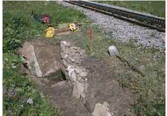
Ein freigelegter Einlassbereich für einen Wasserdurchlass unterhalb der Station Furka. / Une bouche dégagée d'un ponceau en aval de la station Furka.
