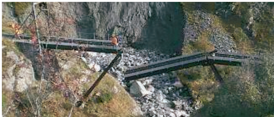
Der Brücken-Mittelteil wird abgesenkt. / La partie médiane du pont est abaissée.
