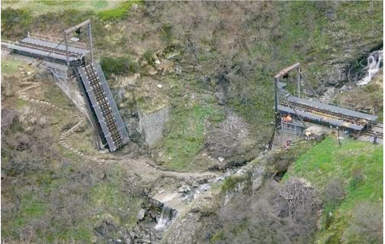
Brücke in Winterstellung. Die Lawinen haben freien Durchgang. Foto vom Mai 2011, vor der Montage. / Pont en position d'hiver. Voie libre aux avalanches. Photo de mai 2011, avant le montage.
