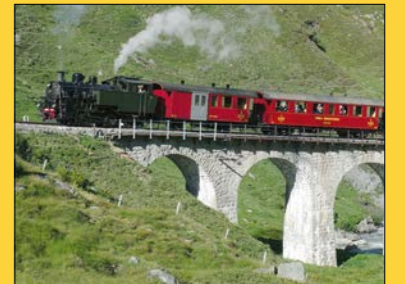
Die Dampflok HG 4/4 Nr. 704 befährt den Steinstafel-Viadukt Foto: Archiv DFB
