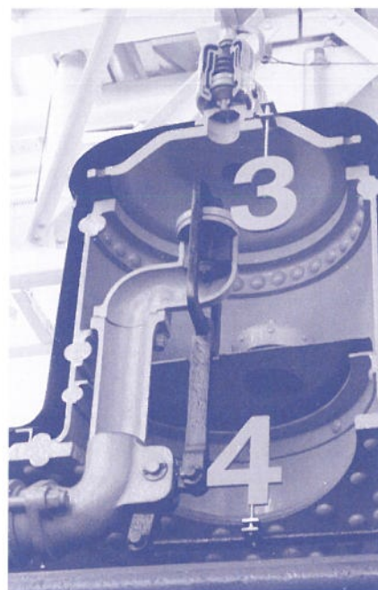
Dampfdom mit Reglerventil
