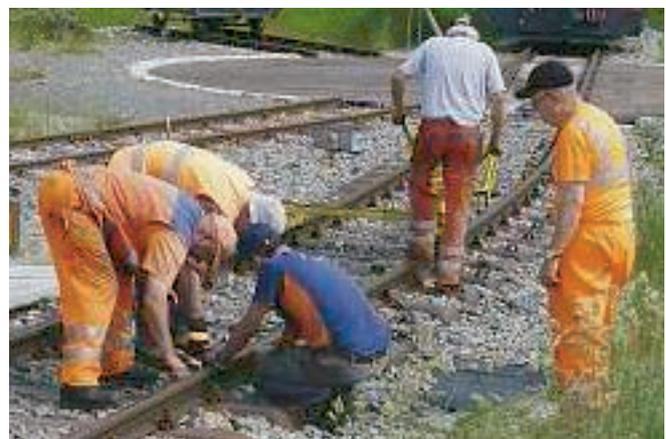
Die Spurerweiterung zur Drehscheibe wird vorgenommen damit die Spurerweiterung zum Radius stimmt. / Le surécartement dans la courbe vers la plaque tournante doit être réglé d'après le rayon
