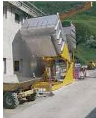
Mulde vom Umschlaggerät wird angehoben. / Relèvement du bac de l'installation de chargement
