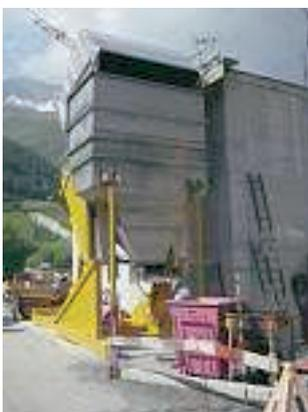
Mulde vom Umschlaggerät in Endstellung oben / Bac de l'installation de chargement en position de fin de course
