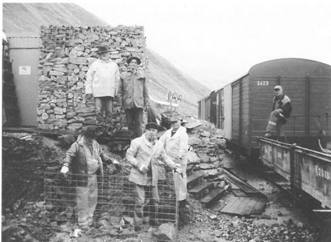
Beim Füllen von Steinkörben in Muttbach. Remplissage de gabions à Muttbach.
