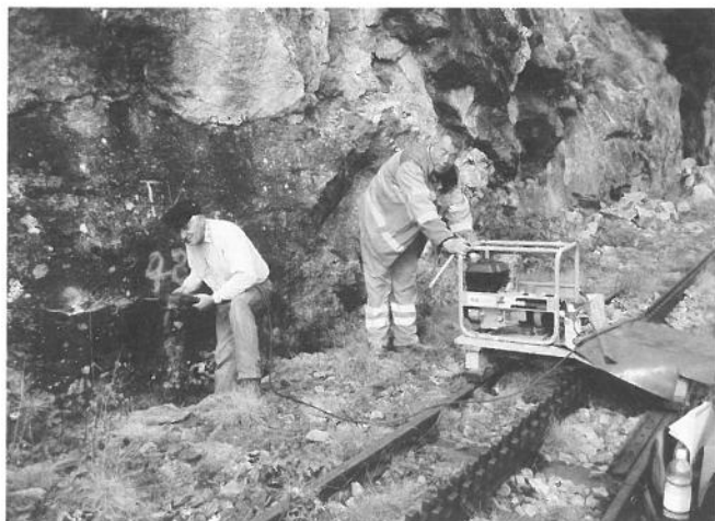
Versicherung der Trasse. – Piquetage du tracé.
