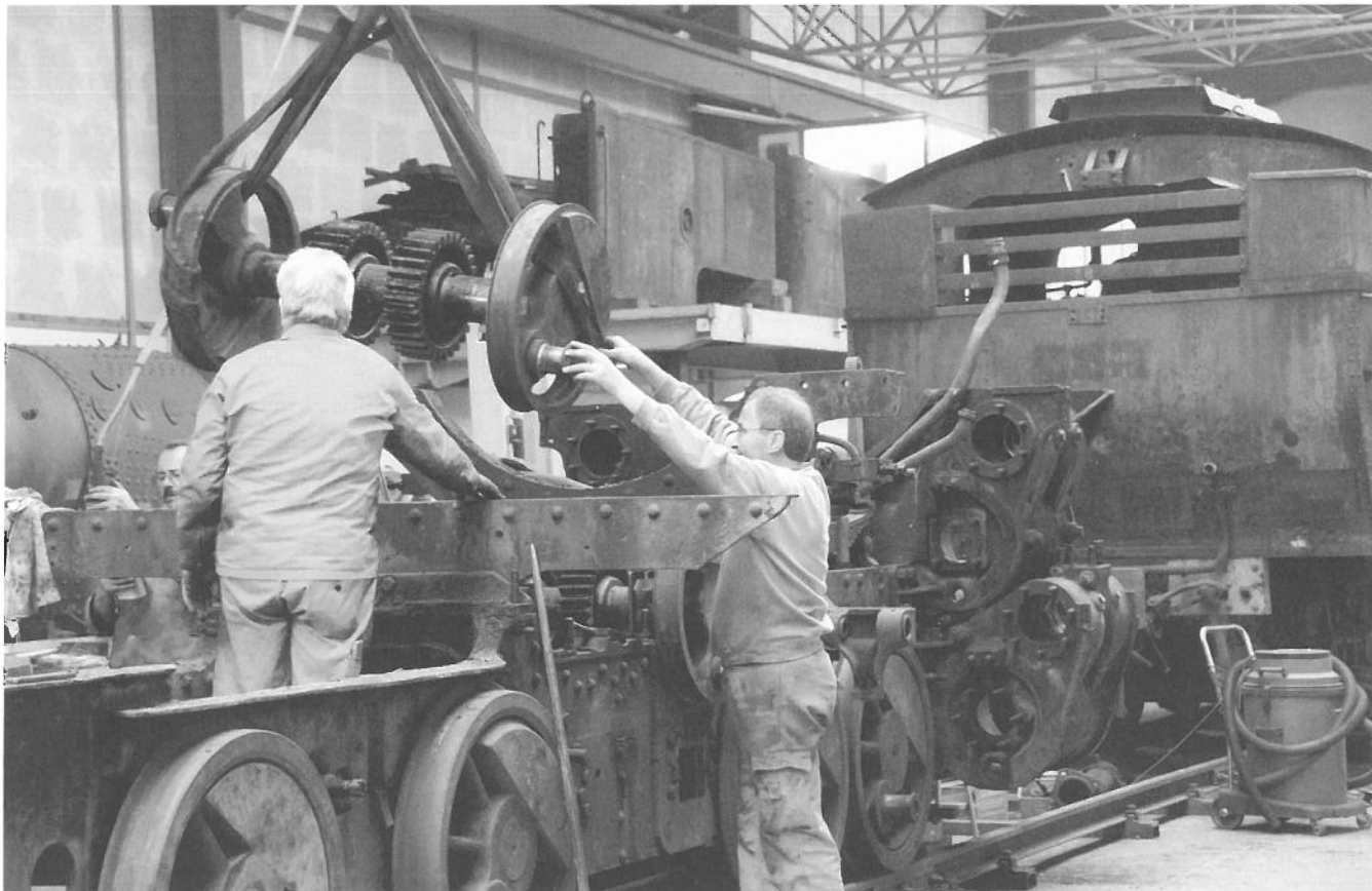
Demontage einer Dampflokomotive HG 4/4 in der Werkstatt Chur. A l'atelier de Coire, démontage d'une locomotive à vapeur HG 4/4.
