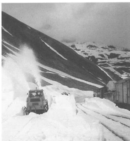
Der Bahnhofplatz auf der Furka wird vom Schnee befreit. Déneigement de la place de la gare de la Furka.
