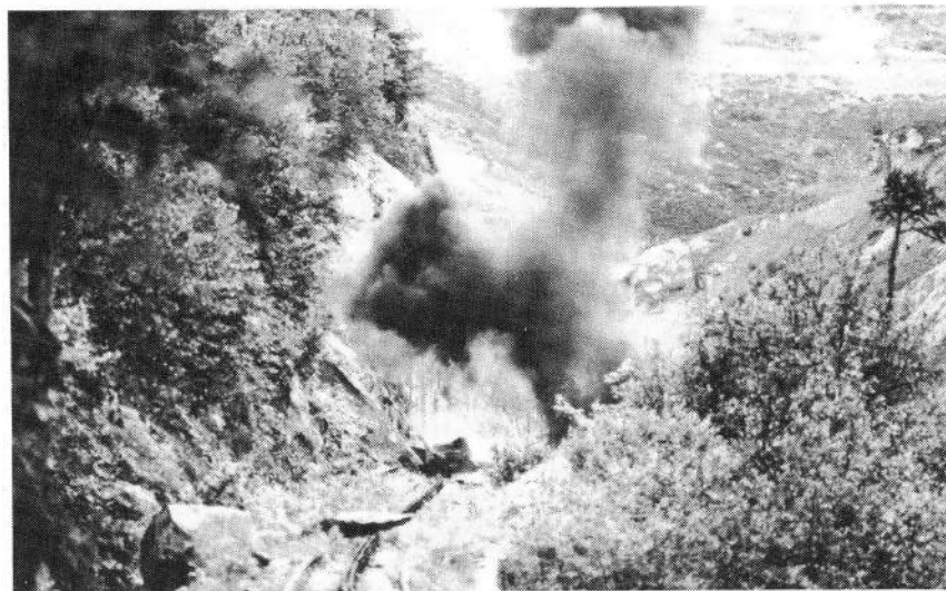
Um die Strecke frei zu bekommen, musste sogar gesprengt werden....
