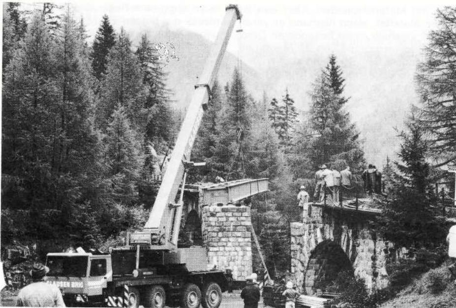
Die Stahlkonstruktion der Lammbrücke wird in die vorbereiteten Auflager gelegt. Feinarbeit mit grossen Geräten war gefragt. Foto bhs
