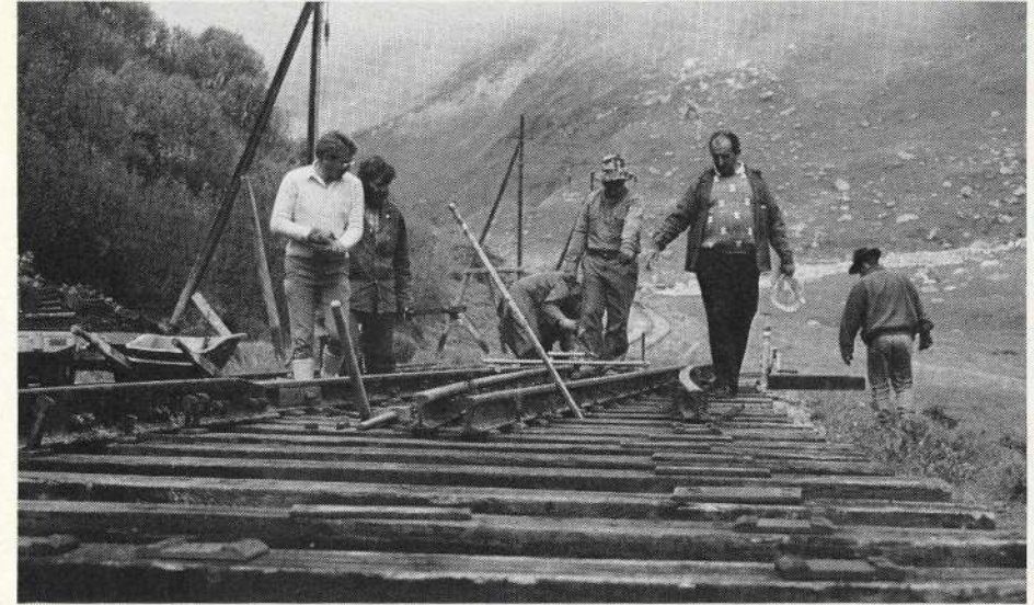
Unter kundiger Leitung von SBB-Personal werden Weichen in Tiefenbach montiert.
