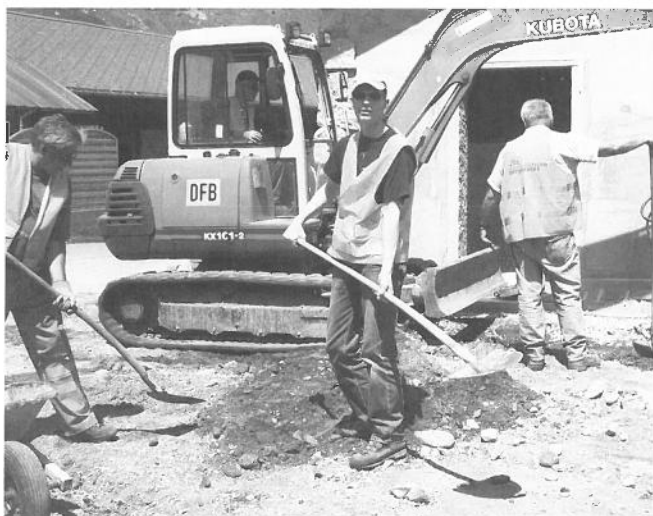
Aushub und Planie. – Fouilles et terrassements.
