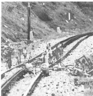
Die Gleisanlage vor der Bearbeitung. La voie avant rectification.
