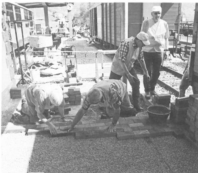
Verlegen von Verbundsteinen. – Pose du dallage.
