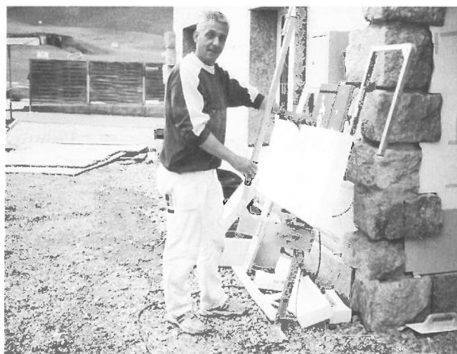
Fredy beim Zuschneiden von Styroporplatten. – Fredy à la coupe du styropor.
