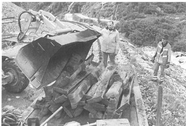
Umlagerung alter Schwellen. – Déplacement d'anciennes traverses.
