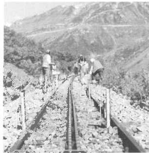
Die Gleisanlage nach der Bearbeitung. La voie après redressement.
