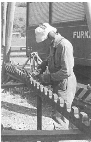
Aufarbeitung von Zahnstangen. Ebarbage de rail-crémaillère.
