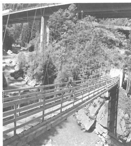
Hängebrücke bei Gurtellen. Pont suspendu près de Gurtellen.
