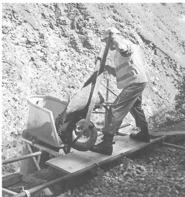
Betonieren an Stützmauern. – Bétonnage de murs de soutènement.
