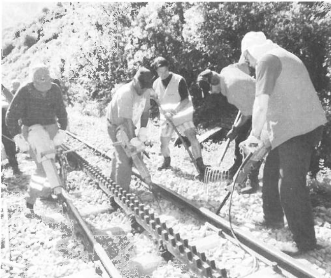
Der Stopftrupp greift an. – Bourrage de la voie.
