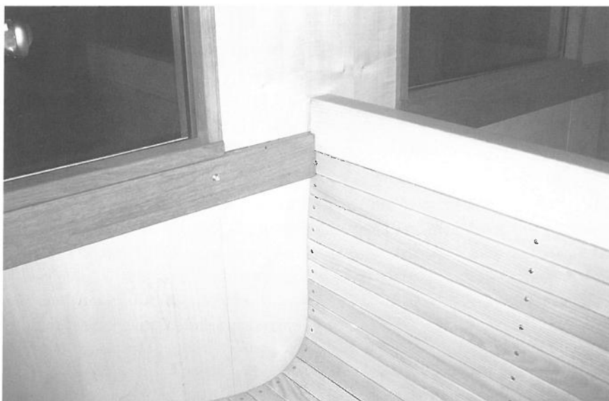
Der Innenausbau ist weit gediehen. – Détail de l'aménagement intérieur du BD 2502.
