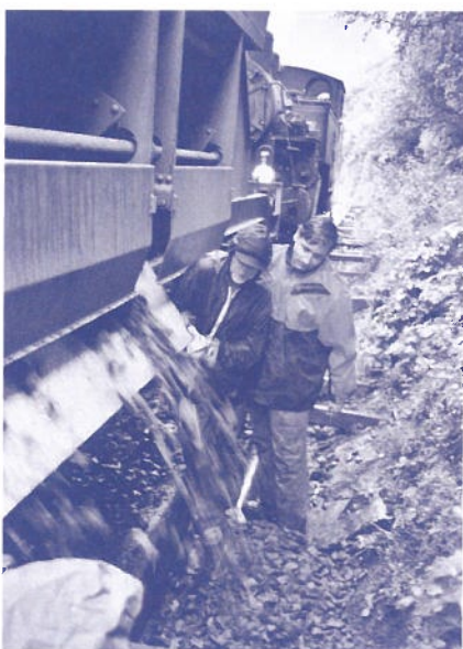
Baueinsatz der Sektion Bern: Schotterablad am 16. Juni oberhalb der Wilerbrücke.
