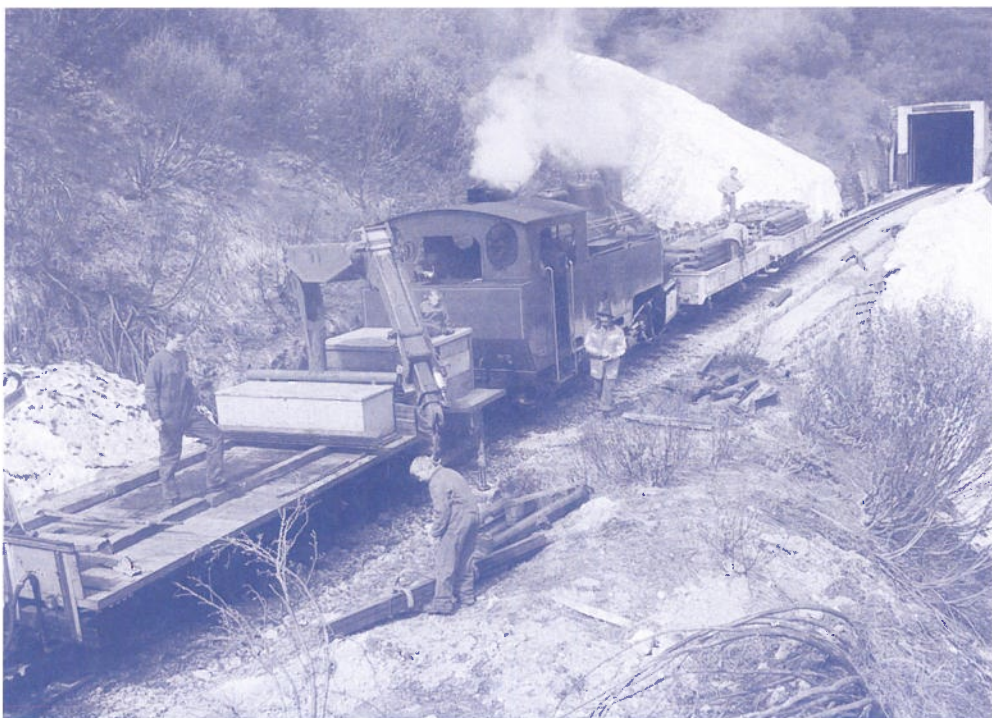
Bauzug mit Dampflok 9 am 2. Juni 2001.
