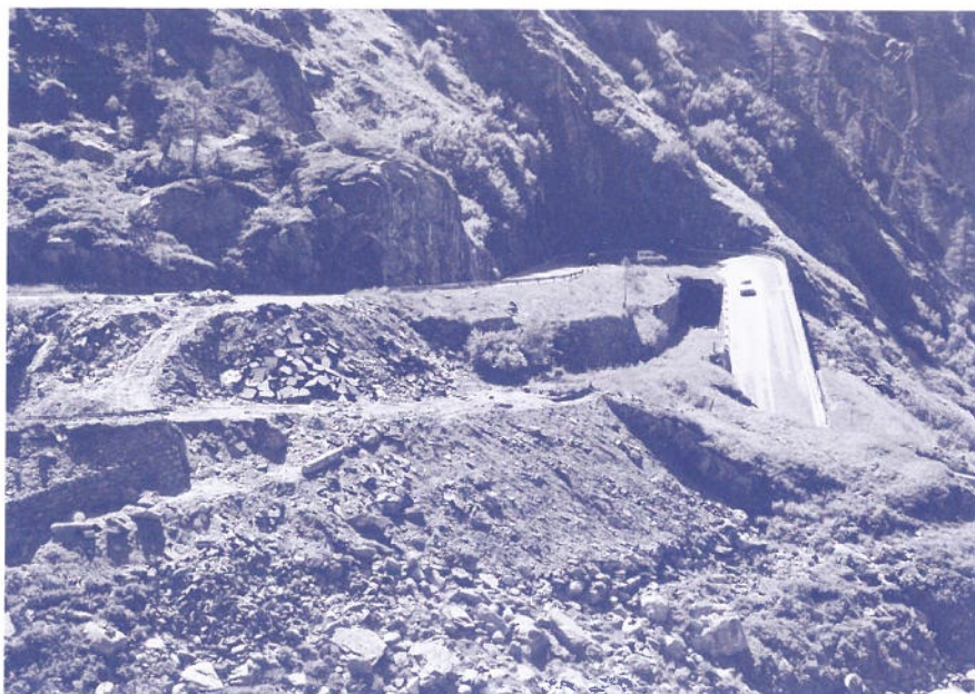
Die allerersten Arbeiten unterhalb Gletsch. Im Hintergrund der Eingang zum Kehrtunnel. Fotos: Julian Witschi
