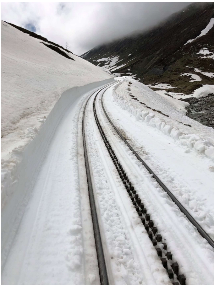
Das Streckengleis nach der bergseitigen Zahnstangeneinfahrt der Station Tiefenbach. Bild: Patrick Smit.
