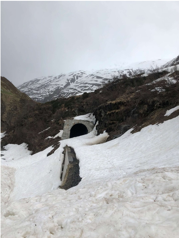
Das bergseitige Portal des Tunnels 2. Bild: Karlheinz Felder.
