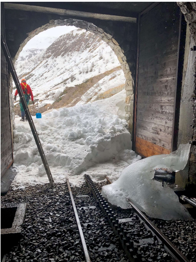
Die talseitigen Tore des Tunnels 1 sind offen. Bild: Karlheinz Felder.
