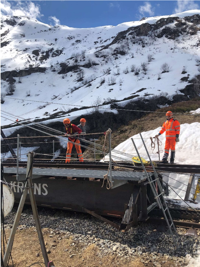
Christoph Spinnler kontrolliert, ob die Stahlseile richtig eingefädelt wurden. Bild: Karlheinz Felder.
