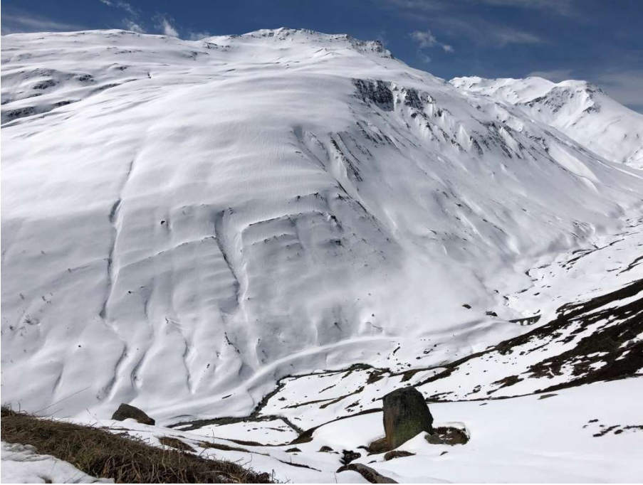
Die Bahnstrecke zwischen der bergseitigen Zahnstangeneinfahrt Tiefenbach und Steinstafelviadukt. Foto: Patrick Smit
