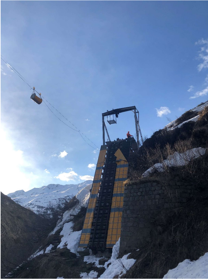
Mit der Material-Seilbahn wird das für den Aufbau notwendige Material vom Windenhaus zum talseitigen Widerlager transportiert. Bild: Karlheinz Felder.
