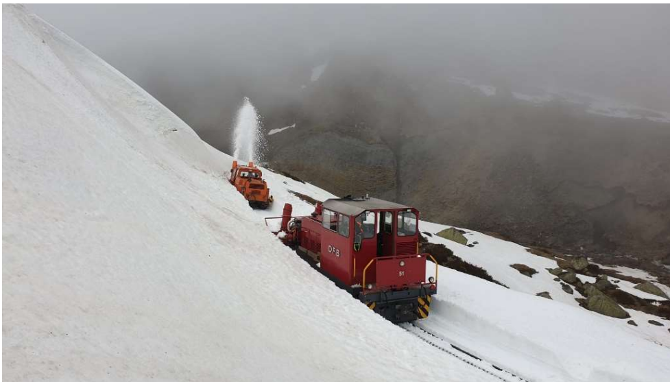
Mit der Lok 6 transportiert Martin Fischer die INTRAC Raupenfräse auf dem Tiefgänger von Realp nach Tiefenbach.
