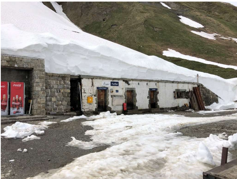
Das Dienst- und Stationsgebäude der Station Furka.
