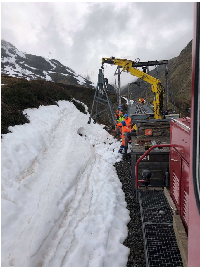
Mit dem Kranwagen wird der Umlenkbock der Steffenbachbrücke neben der Steffenbachbrücke deponiert. Bild: Patrick Smit.
