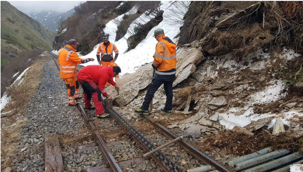
Mit Stockwinden bewegen Thomas Holder, Federico Rossi, Patrick Smit, Martin Wieland und Bruno Zimmermann bei Starkregen die Schieferplatten aus dem Profil. Bild: Bruno Zimmermann.
