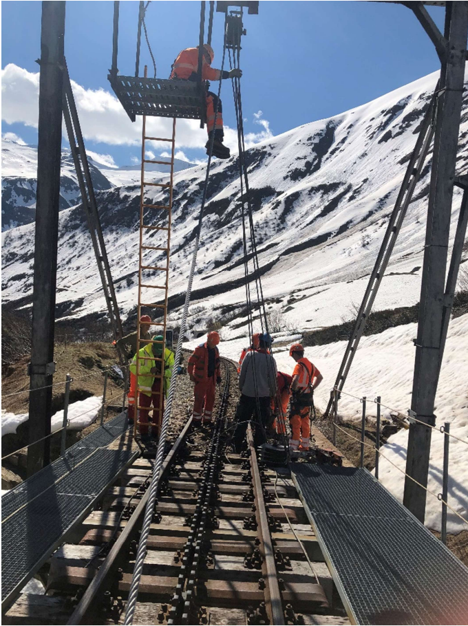
Nachdem das untere Brückenelement verlascht ist, müssen die Flaschenzüge für das Verschieben des oberen Brückenelements neu eingefädelt werden. Bild: Karlheinz Felder.
