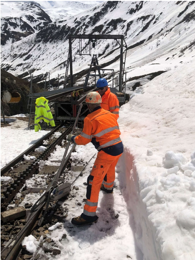
Das Schneeräumungsteam bei den Vorbereitungsarbeiten für das Aufstellen der Steffenbachbrücke. Bild: Karlheinz Felder.
