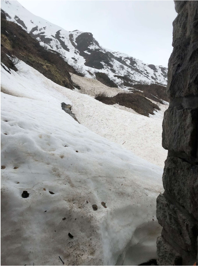
Zwischen Tunnel 2 Bergseite und Tunnel 1 Talseite liegen auf dem Bahntrasse an einem Punkt höchstens 8,5 m Schnee. Vor 2 Jahren lag hier vom bergseitigen Portal des Tunnels 2 bis kurz vor dem talseitigen Portal des Tunnels 1 fast 18 m hart gepressten Lawinenschnee. Bild: Karlheinz Felder.
