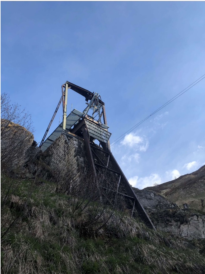
Das bergseitige Brückenelement in der Winterstellung. Bild: Karlheinz Felder.
