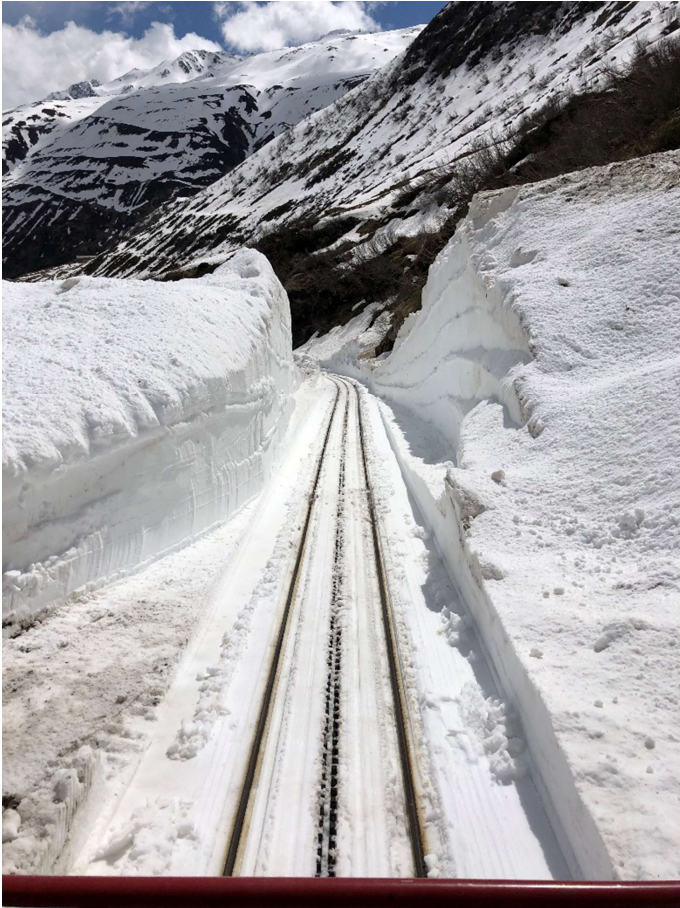
Nach 3 Stunden Fräsen ist der Schneerutsch zwischen Tunnel 2 und Tunnel 1 überwunden. Bild: Patrick Smit.
