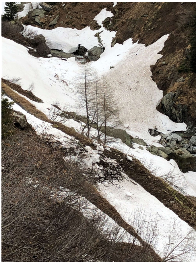
Ein «dreckiger» zum Glück geringmächtiger Schneerutsch auf dem Bahntrasse beim Lehnenviadukt «Mässweid». Foto: Patrick Smit.
