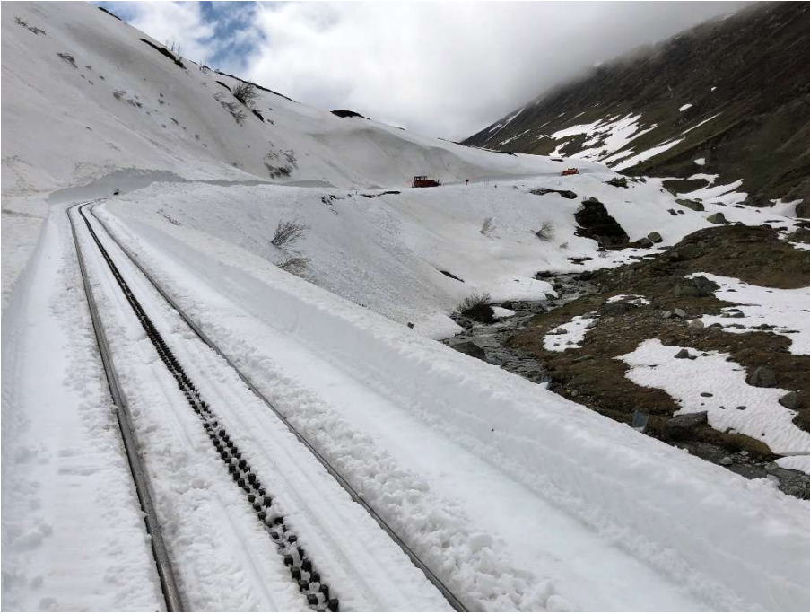
Die HGm 51 mit Anbaufräse und die INTRAC Raupenfräse zwischen Steinsäumli und dem Steinstafelviadukt. Bild: Patrick Smit.
