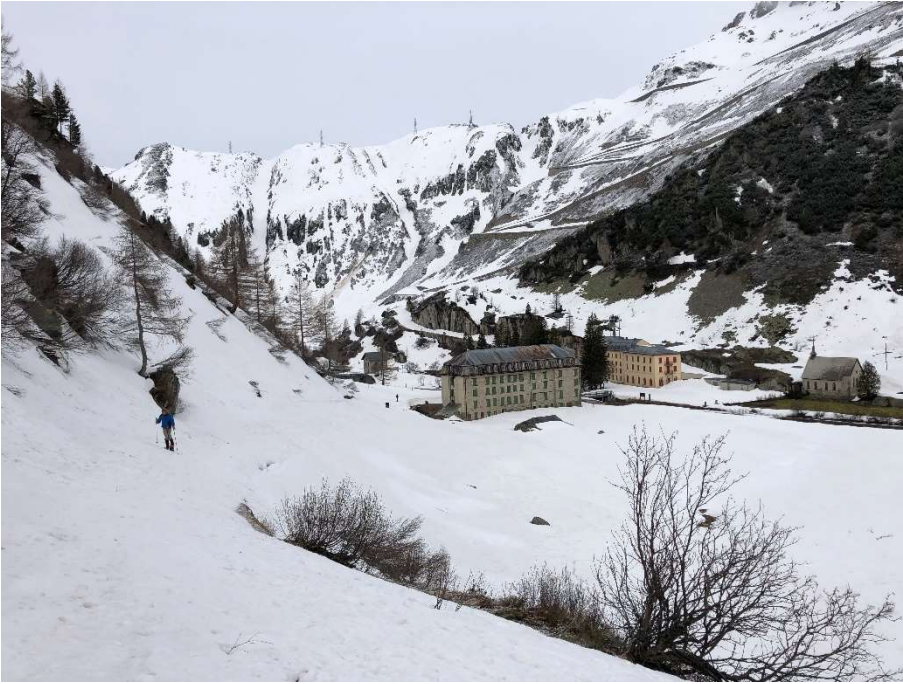
Die zahlreichen Schneerutsche zwischen Gletsch und Bahnübergang «Furkastrasse» machen das Fortkommen auf der Bahnstrecke mühsam und gefährlich. Foto: Patrick Smit.
