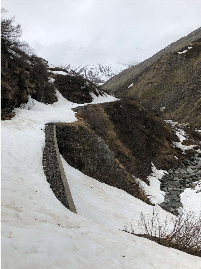
Bagger und HGm 51 mit Anbaufräse werden den Schnee zwischen Tunnel 1 Bergseite und Steffenbachbrücke problemlos räumen. Bild: Karlheinz Felder.
