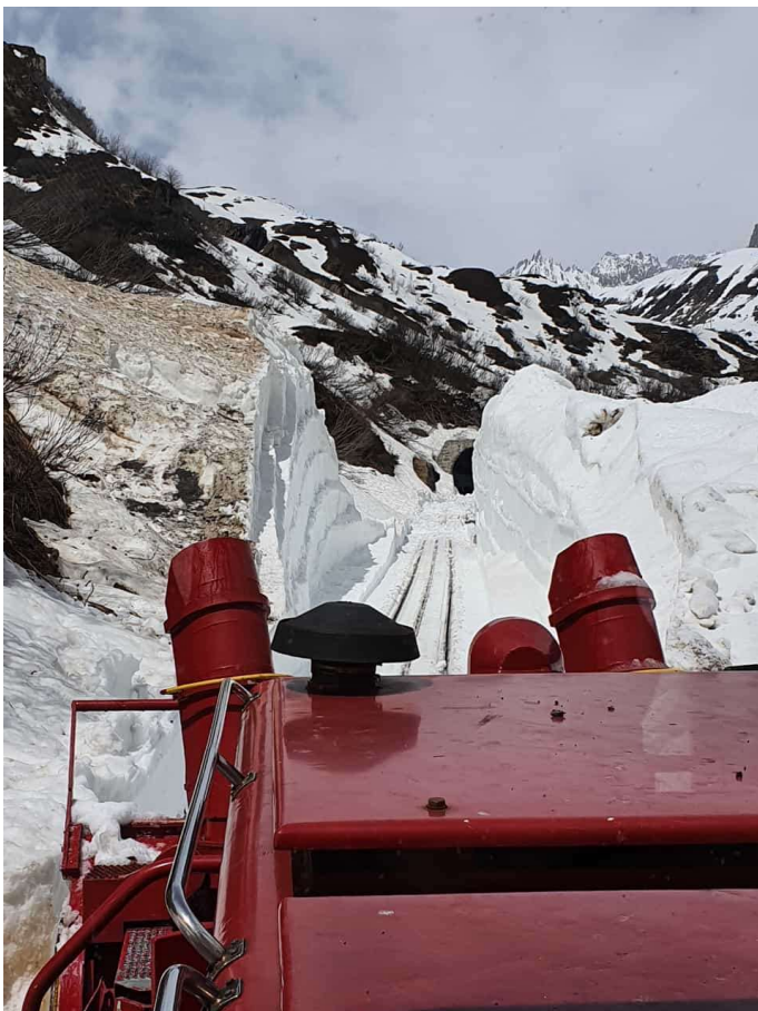
Die HGM 51 mit Anbaufräse räumt den letzten Schnee vom Bahntrasse zwischen Tunnel 2 und Tunnel 1. Bild: Michael Bühler.
