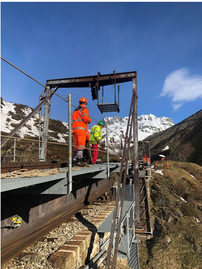
Mit einem Hilfsseil ziehen Reto Alber und Toni Meier das Stahlseil über das Steffenbachtobel. Bild: Karlheinz Felder.
