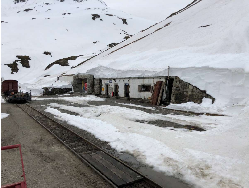
Die Station Furka nach dem vorläufigen Abschluss der Auswintungsarbeiten.
