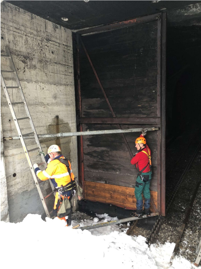
Fritz Gerber und Christoph Spinnler lösen die aussen- seitigen Verstrebungen des talseitigen Tors des Tun- nels 1. Bild: Karlheinz Felder.
