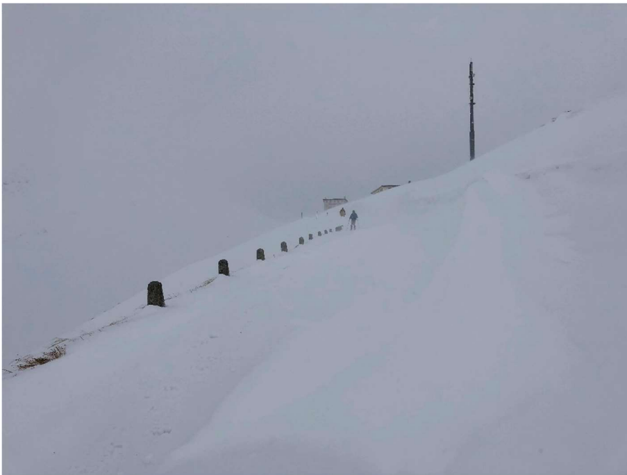
Abstieg von der Furkapasshöhe nach Tiefenbach. Das Tiefbauamt des Kantons Uri hat die Passstrasse von Realp bis Furkapasshöhe bereits geräumt. Die Schneefälle und die starken Winde führen an vielen Orten zu zahlreichen Schneeverwehungen auf der Passstrasse.
