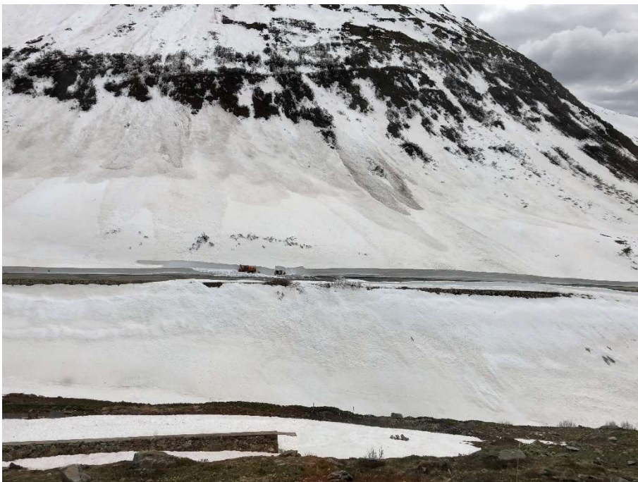
Der Arbeitsplatz beim Bahnübergang Furkastrasse von der Zufahrtsstrasse zur Station Muttbach-Belvédère her gesehen. Bild: Patrick Smit.
