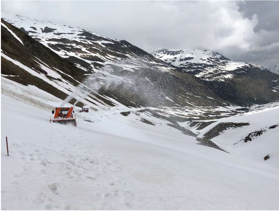
Die INTRAC Raupenfräse und die HGm 51 mit Anbaufräse in den zahlreichen Schneerutschen kurz vor der Station Furka.
