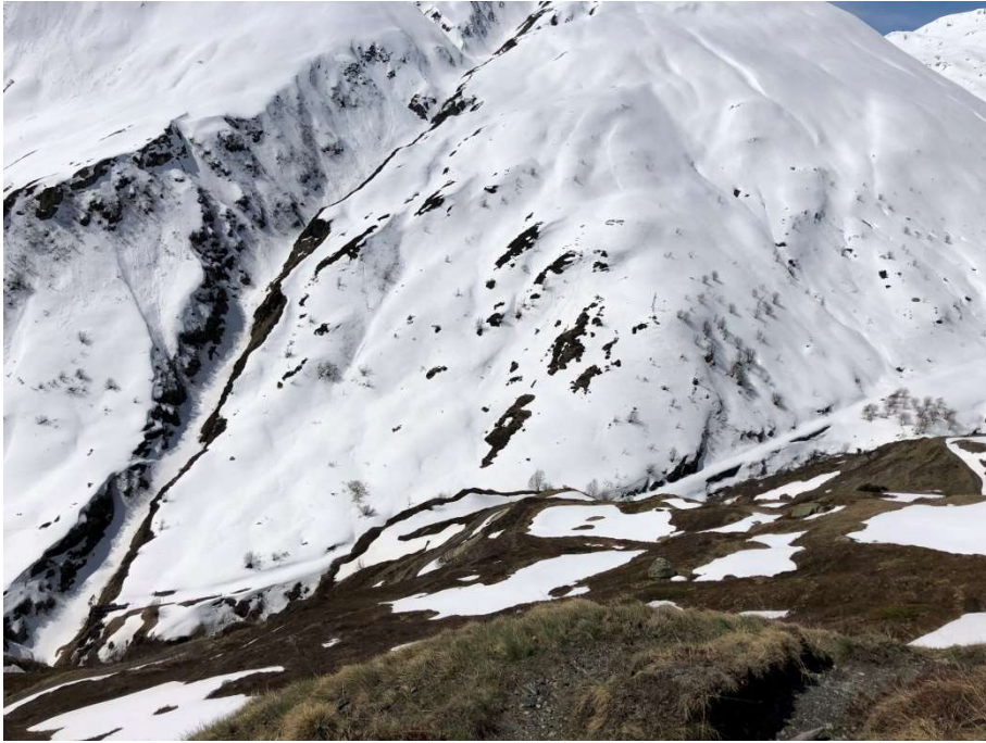
Die Bahnstrecke zwischen der Steffenbachbrücke und der Wasserfassung Tiefenbach. Foto: Patrick Smit
