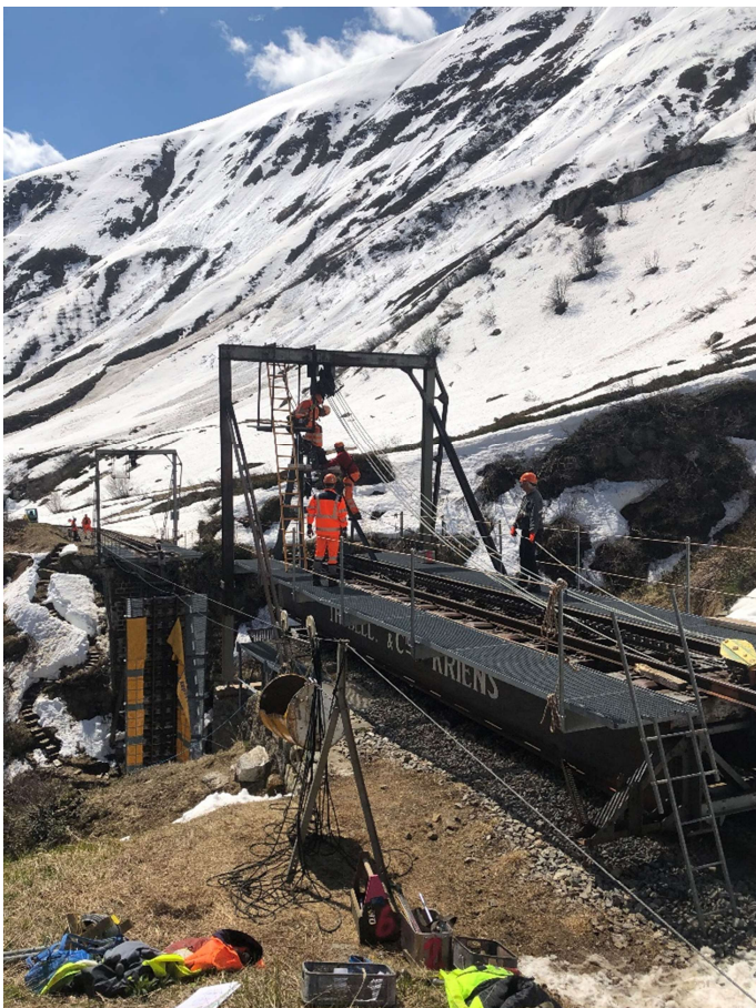
Einfädeln der Flaschenzüge für den Vershub des oberen Brückenelements in die Sommerstellung. Bild: Karlheinz Felder.
