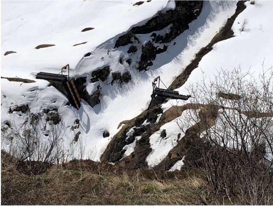
Die Steffenbachbrücke. Foto: Patrick Smit
