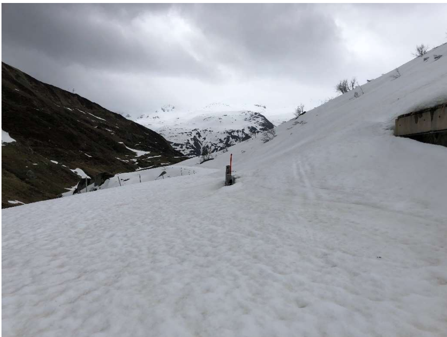
Die Bahnanlagen der Station Tiefenbach liegen unter einer geringmächtigen weichen Schneedecke. Das Wasserreservoir ist bereits völlig schneefrei. Bild: Patrick Smit.
