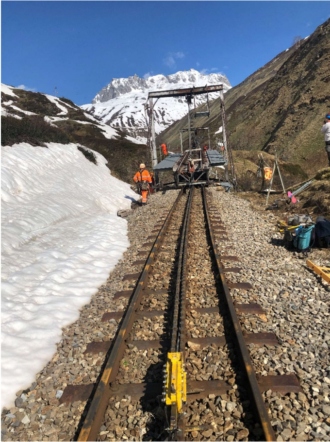
Langsam bewegt sich das untere Brückenelement in dessen Sommerstellung. Der Vershub ist mit einem Sicherheitsseil und einer Seilbremse gesichert. Bild: Karlheinz Felder.
