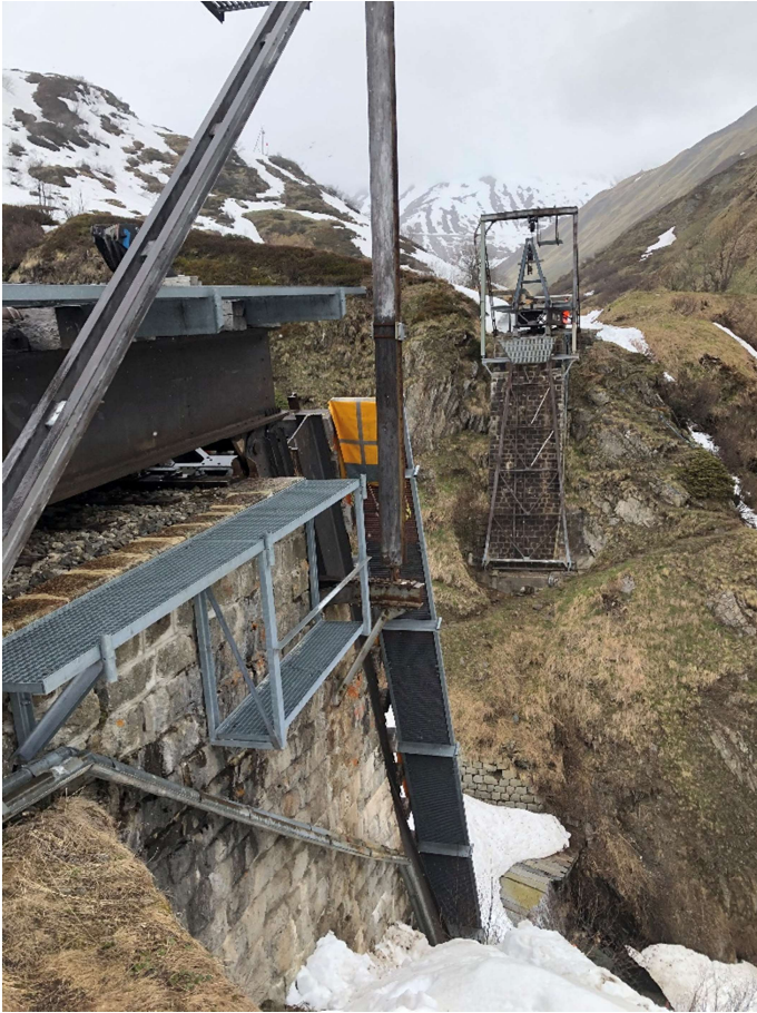
Das bergseitige Widerlager ist völlig schneefrei. Bild: Karlheinz Felder.
