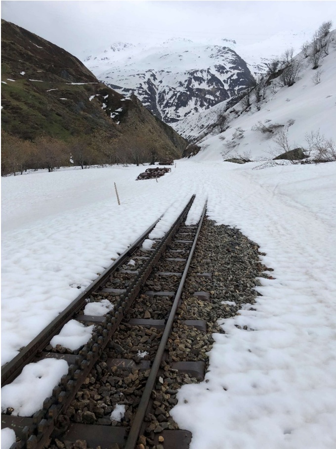
Die Bahnstrecke zwischen der Steffenbachbrücke und Tiefenbach kann problemlos mit der HGm 51 mit Anbaufräse geräumt werden. Bild: Patrick Smit.
