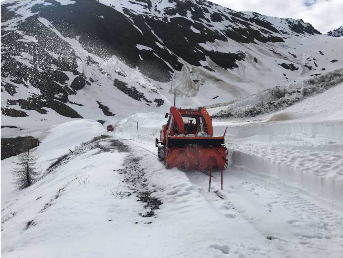
9.6.2021: Geschafft!! Die Zahnstangeneinfahrt der Station Muttbach-Belvédère ist erreicht. Bild: Luc Wullschleger.
