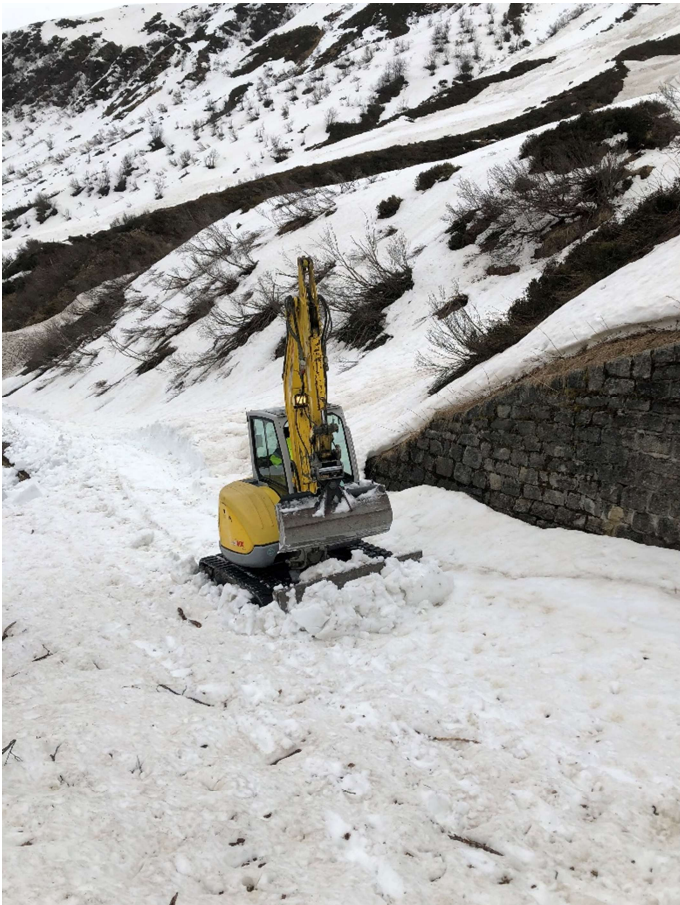
Mit dem Bagger arbeitet sich Kurt Hohl zum Tunnel 1 vor. An der Bergseite des Tunnels 1 wird er für die INTRAC Raupenfräse eine Rampe bauen. Bild: Karlheinz Felder.
