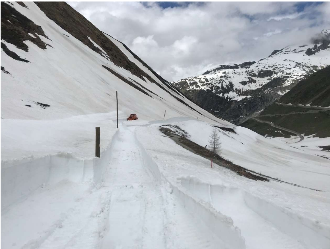
8.6.2021: Der vordere Holzpfahl markiert die Weiche zum Stumpengleis. Der nächste Pfahl ragt auf der Höhe der talseitigen Einfahrweiche der Station Muttbach-Belvédère aus dem Schnee. Die INTRAC Raupenfräse fräst im Moment das Stumpengleis frei. Bild: Luc Wullschleger.
