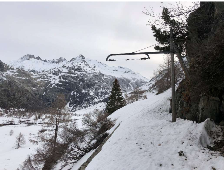
Der Fahrleitungsmast oberhalb der Station Gletsch. Foto: Patrick Smit.
