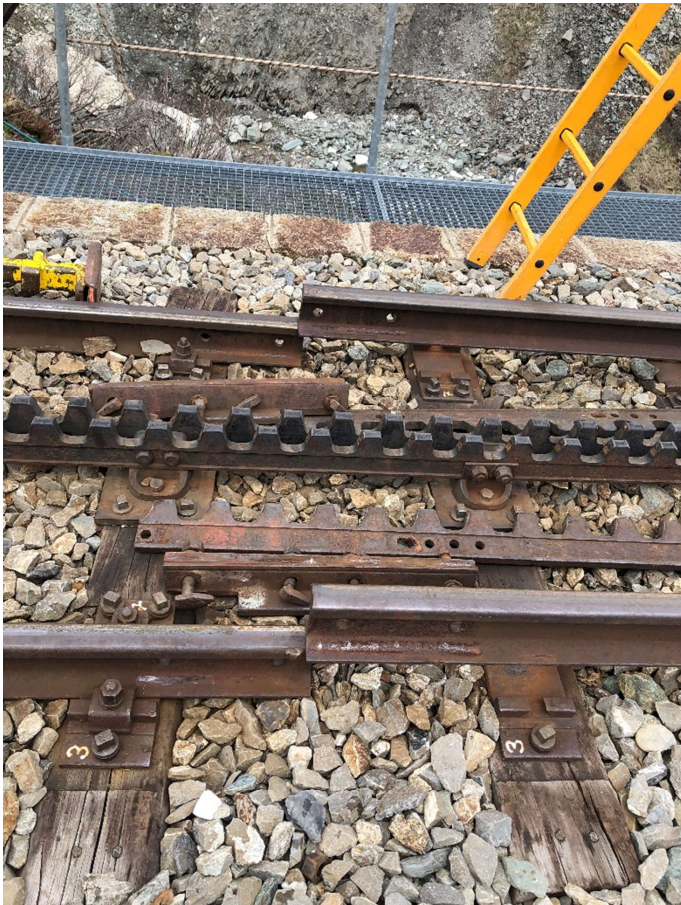
Die Gleise und Zahnstangen sind wegen der tageszeitlichen Erwärmung und Ausdehnung zu lang. Aus diesem Grund können die Laschen und Bolzen am Übergang oberes Widerlager - oberes Brückenelement noch nicht montiert werden. Bild: Karlheinz Felder.
