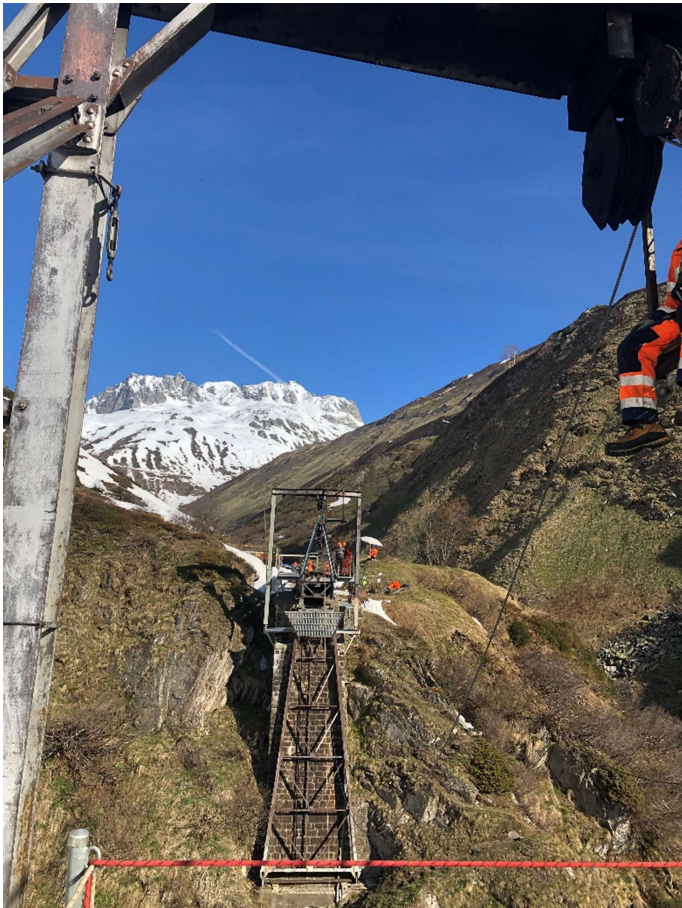
Während die Kollegen die Stahlseile korrekt einfädeln, kümmert sich Ruedi Tobler um die provisorischen Absturzsicherungen. Bild: Karlheinz Felder.
