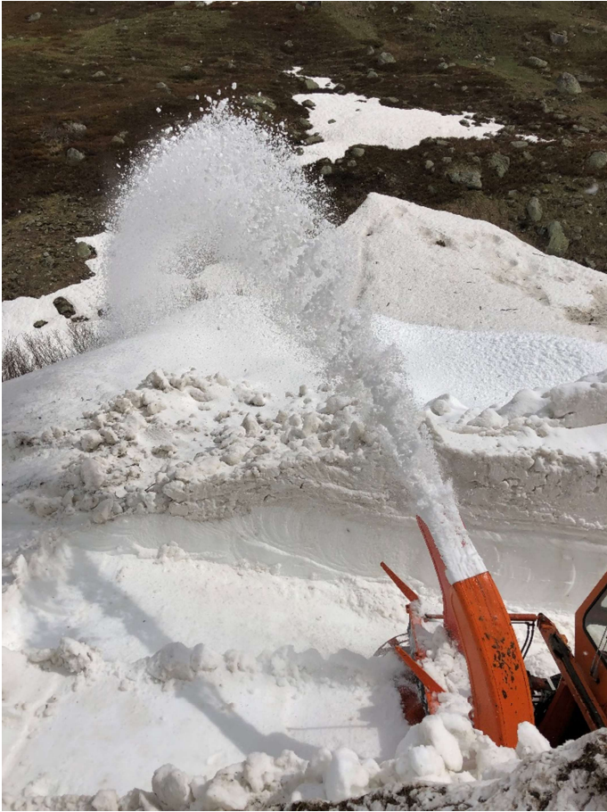
Die INTRAC Schneefräse kurz vor dem Kulminationspunkt des Schneerutsches zwischen Tunnel 2 und Tunnel 1. Bild: Patrick Smit.
