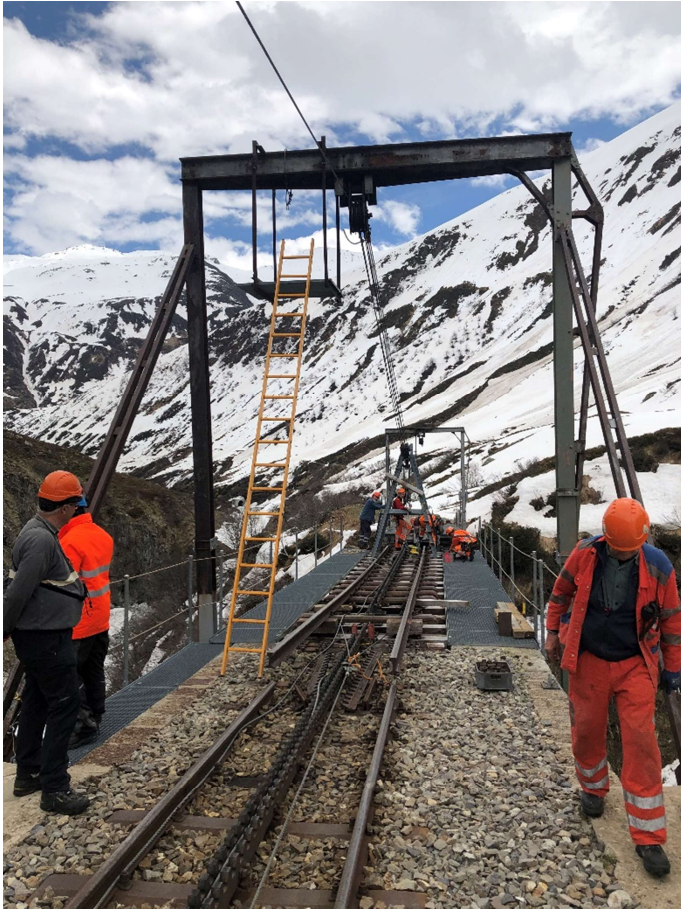
Das obere Brückenelement ist in der Sommerstellung. Bild: Karlheinz Felder.
