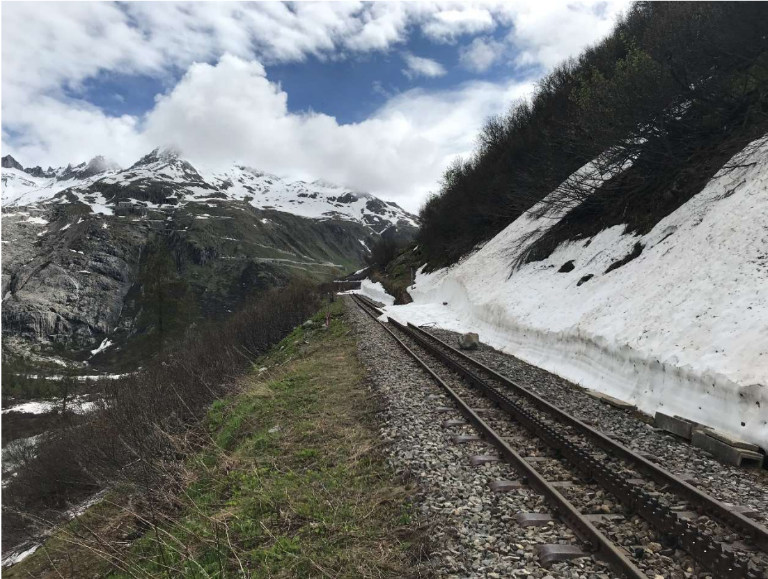
8.6.2021: Die Bahnstrecke oberhalb der Hilfsbrücke 5 Tage nachdem eine INTRAC Raupenfräse den Schnee von diesem Streckenabschnitt gefräst hat. Bild: Luc Wullschlegler.
