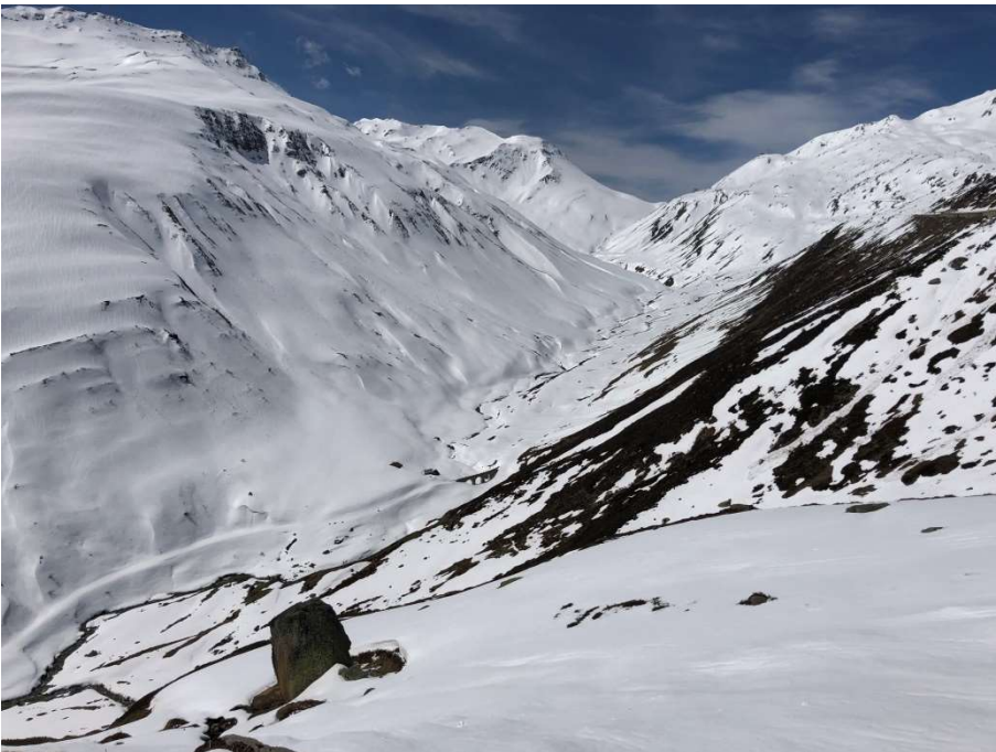
Blick vom Weiler Tiefenbach Richtung Furka-Passhöhe. Oberhalb des Steinstafelviadukts ist die Bahnstrecke bis zum ostseitigen Portal des Scheiteltunnels gut sichtbar. Foto: Patrick Smit
