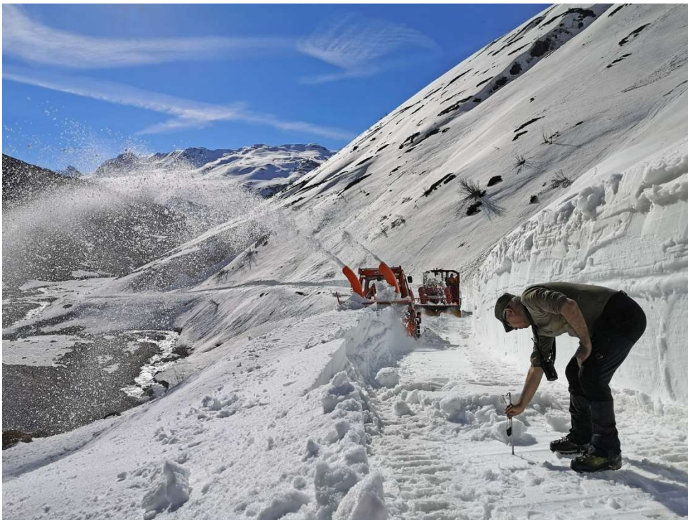
Patrick Smit misst die Mächtigkeit der Schneedecke nach dem ersten Schnitt. Nach dem ersten Schnitt liegt das Gleis in einer Tiefe von mehr als 2 m.
