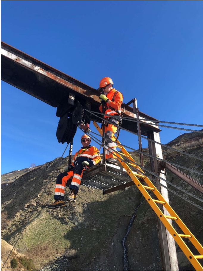
Anschliessend fädeln Fritz Gerber und Samuel Kier das Stahlseil in die talseitigen Umlenkrollen ein. Bild: Karlheinz Felder.
