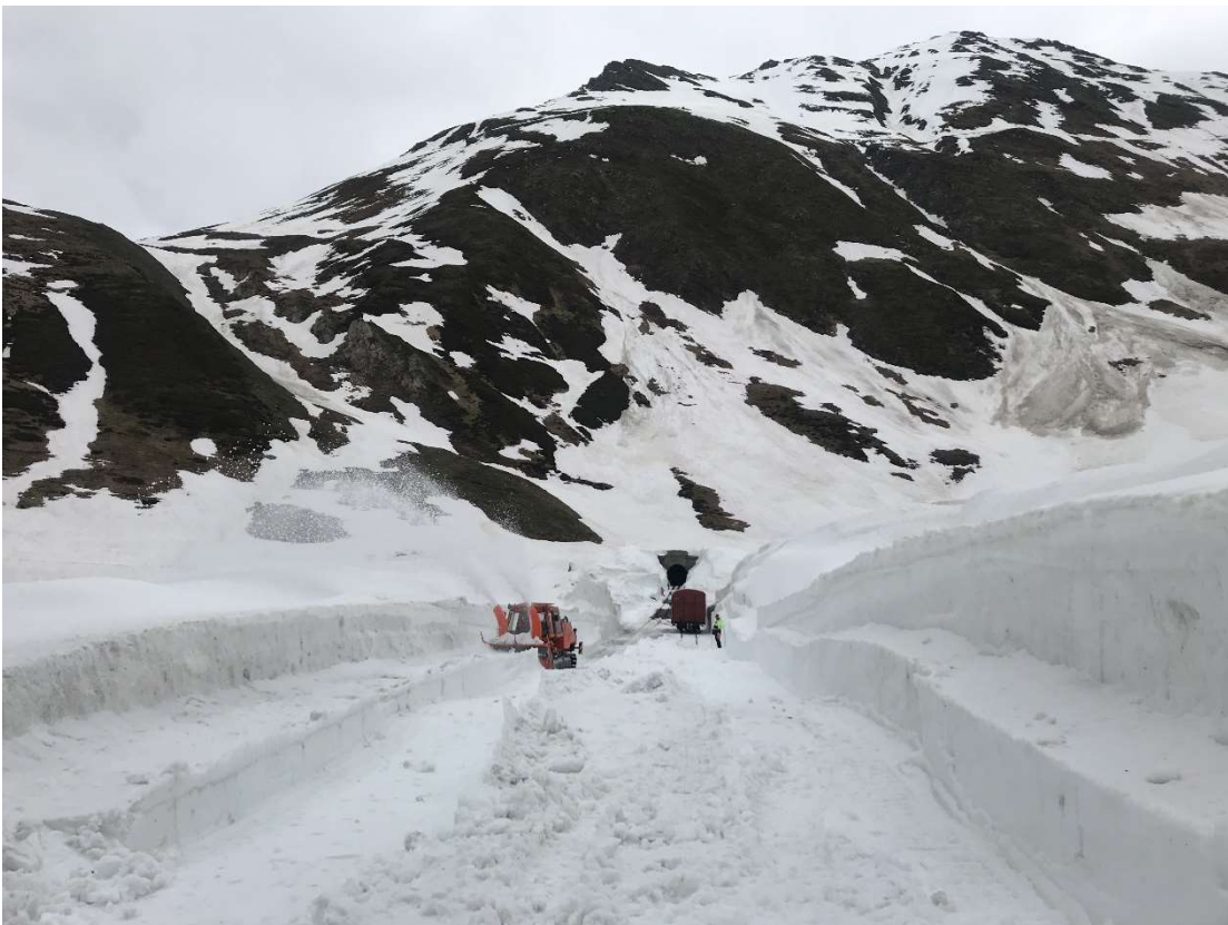
8.6.2021: Stephan Stauber beim Fräsen in der Station Muttbach-Belvédère. Im Hintergrund ist das Westportal des Scheiteltunnels sichtbar. Bild: Luc Wullschleger.
