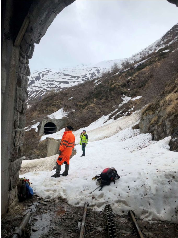
Blick vom Tunnel 2 Talseite zum Tunnel 3 Bergseite. Die schweren Stützbalken des bergseitigen Tors des Tunnels 1 sind noch nicht versetzt. Christoph Spinnler macht eine Verbindungskontrolle mit der Lawinenwache. Bild: Karlheinz Felder.
