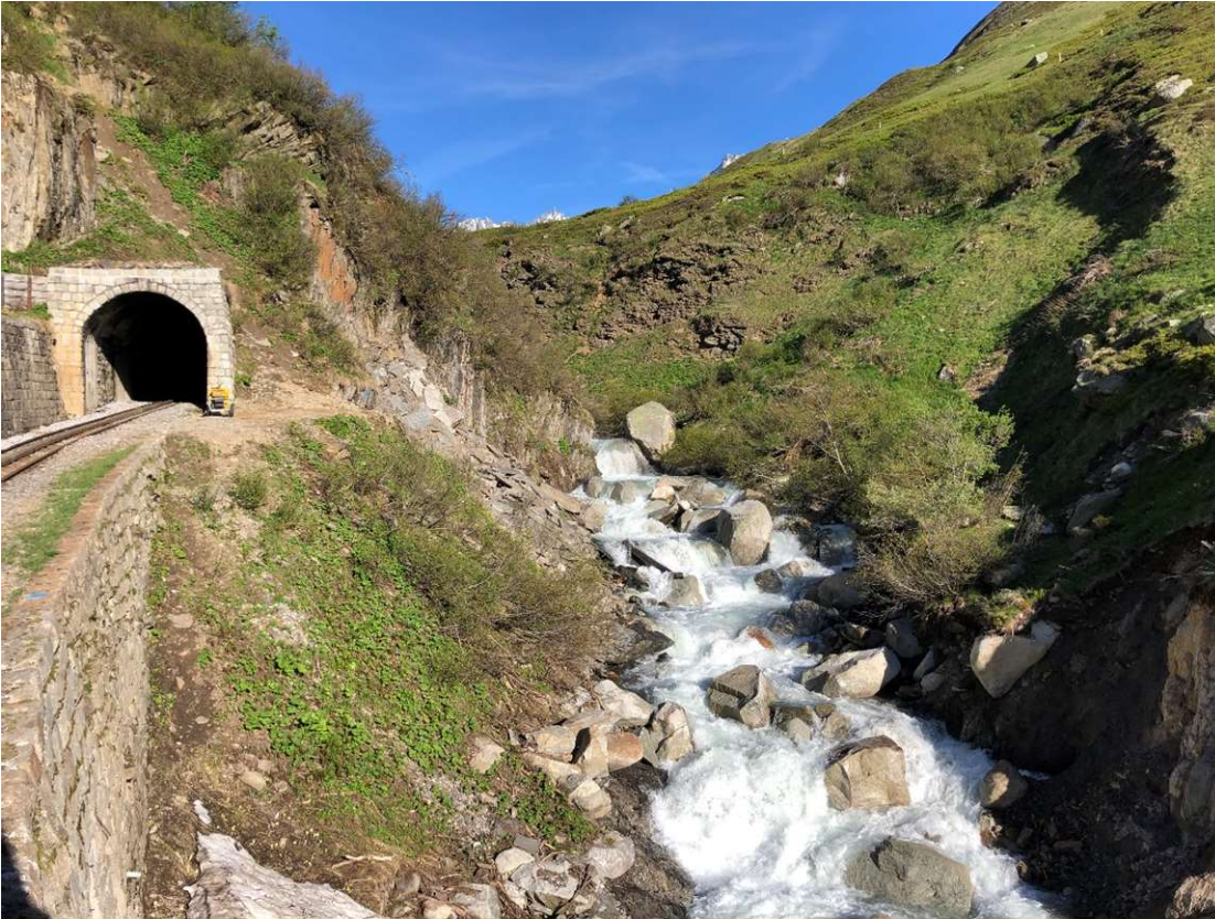
12.6.2021: Auf der Fahrt zu den Arbeitsplätzen unterhalb des Tunnels 3. Die Furkareuss führt viel Schmelzwasser. Bild: Patrick Smit.
