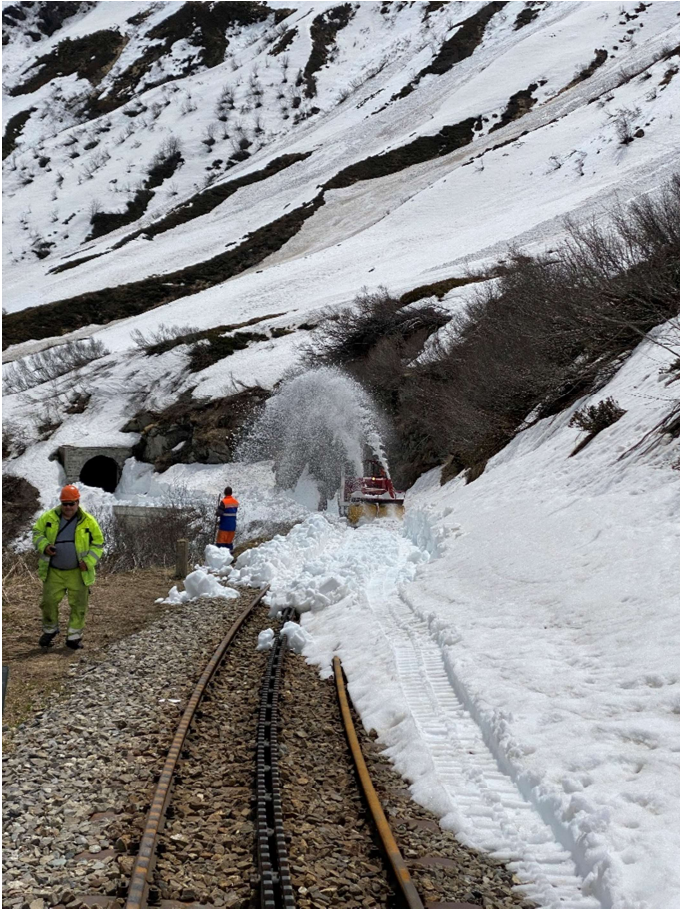
Die HGm 51 mit Anbaufräse kurz vor der Steffenbachbrücke. Bild: Reto Alber.
