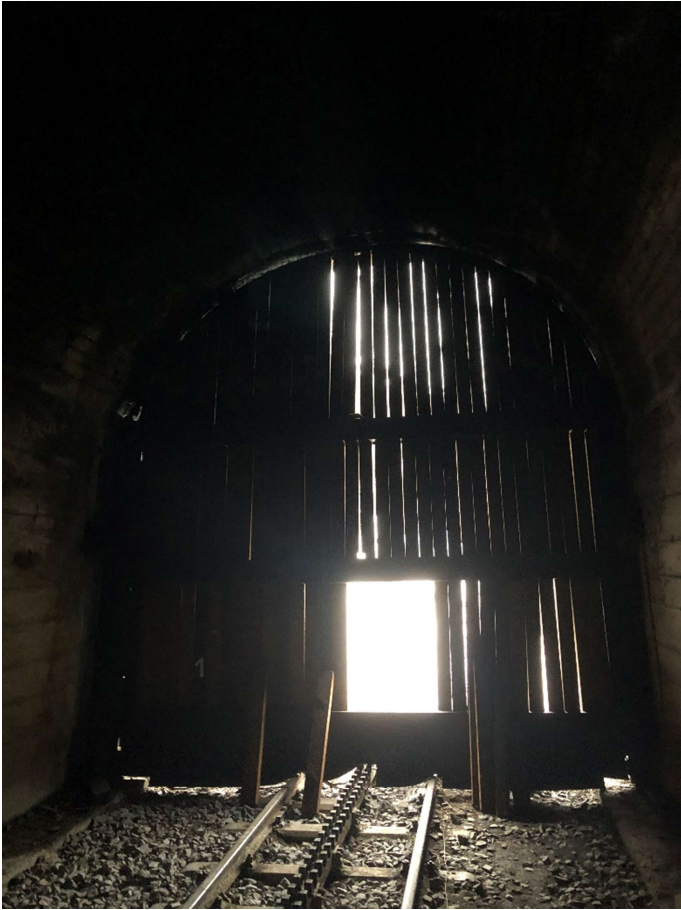
Christoph Spinnler, Karlheinz Felder, Fritz Gerber und Fred Schönthal öffnen das Tunneltor beim bergseitigen Portal des Tunnels 3. Bild: Karlheinz Felder.
