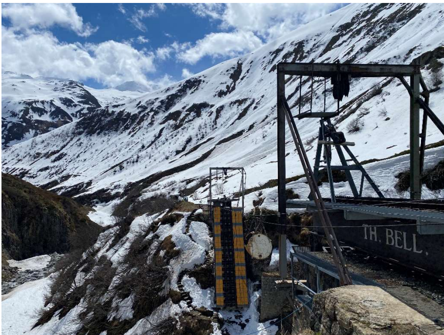
Die Steffenbachbrücke in der Frühlingssonne. Bild: Reto Alber.
