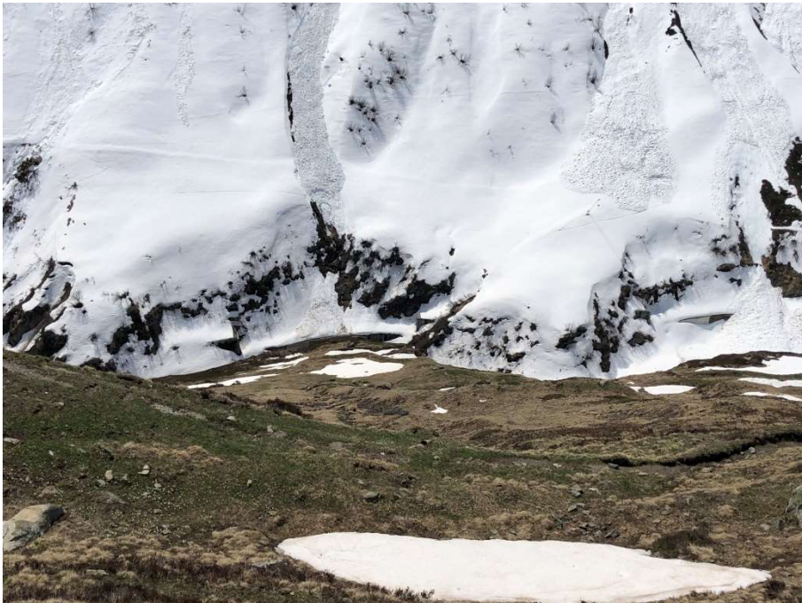
Die Bahnstrecke zwischen dem bergseitigen Portal des Tunnels 3 und dem talseitigen Portal des Tunnels 2. Foto: Patrick Smit
