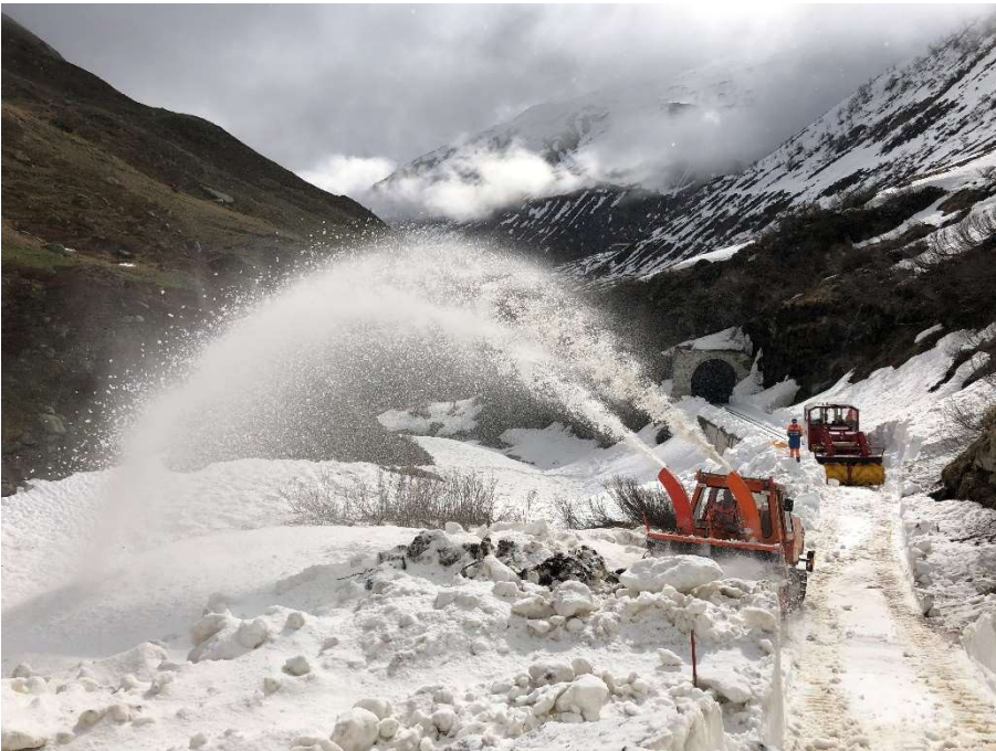
Oberhalb des Tunnels 2 räumt Thomas Holder den Schneerutsch vom Bahntrasse. Im Hintergrund wartet die HGm 51 mit Anbaufräse auf den Einsatz. Bild: Patrick Smit.
