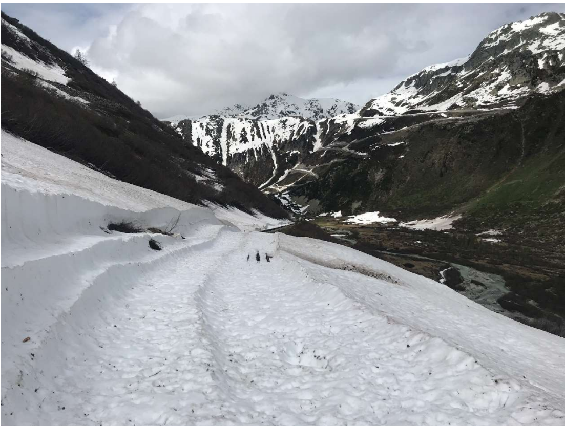
8.6.2021: Die Bahnstrecke unterhalb der Hilfsbrücke 5 Tage nachdem eine INTRAC Raupenfräse den Schnee von diesem Streckenabschnitt passiert hat. Bild: Luc Wullschlegler.
