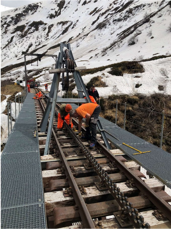
Urs Züllig und Ulf Weidle verschrauben die Zahnstangen zwischen dem oberen und mittleren Brückenelement. Bild: Karlheinz Felder.
