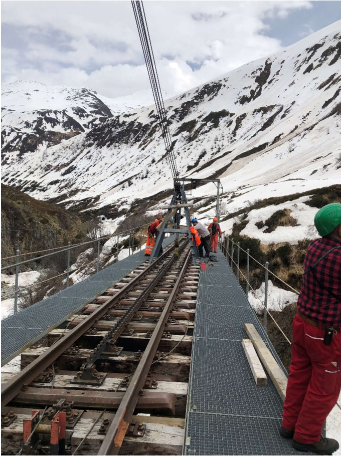
Am frühen Nachmittag wird das mittlere Brückenelement in die Sommerposition gehoben. Bild: Karlheinz Felder.
