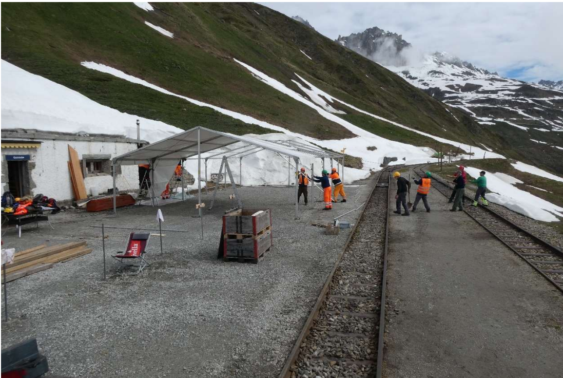
9.6.2021: Die Dachplanen werden über die Zeltstangen gezogen. Bild: Ruedi Tobler.
