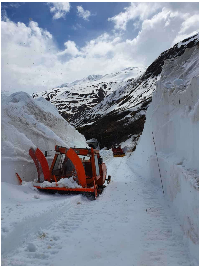
Die INTRAC Fräse im Schneekanal. Bild: Michael Bühler.
