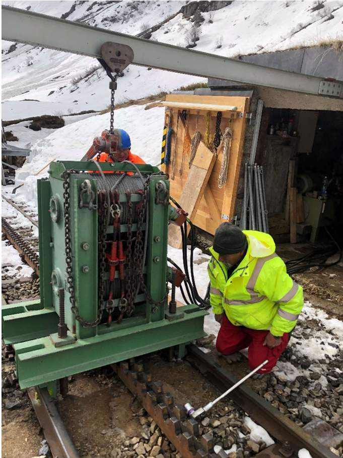
Montage der Hydraulikwinde an den hierzu vorgesehenen Fixpunkten vor dem Windenhaus. Bild: Karlheinz Felder.
