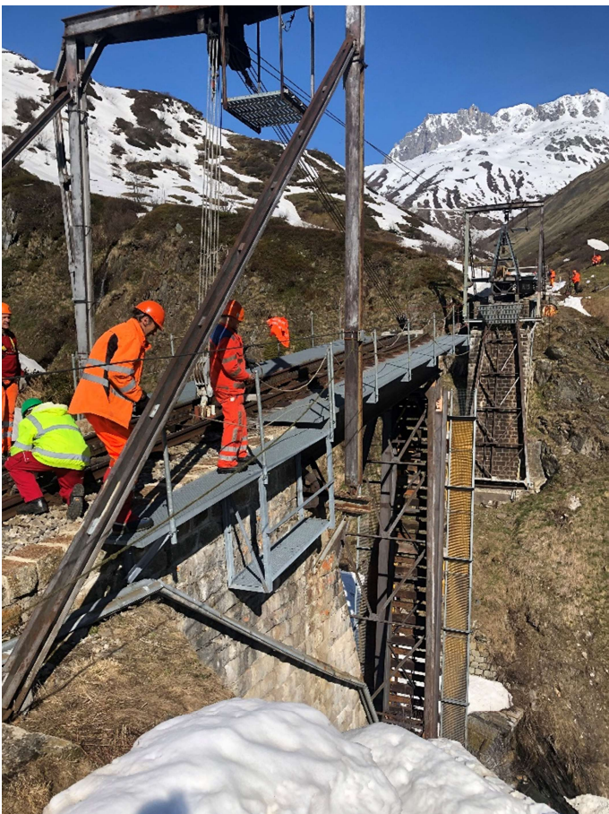
Das untere Brückenelement ist in der Sommerstellung. Die unteren und oberen Seilwinden tragen das untere und mittlere Brückenelement, bis das untere Brückenelement verlascht ist. Bild: Karlheinz Felder.
