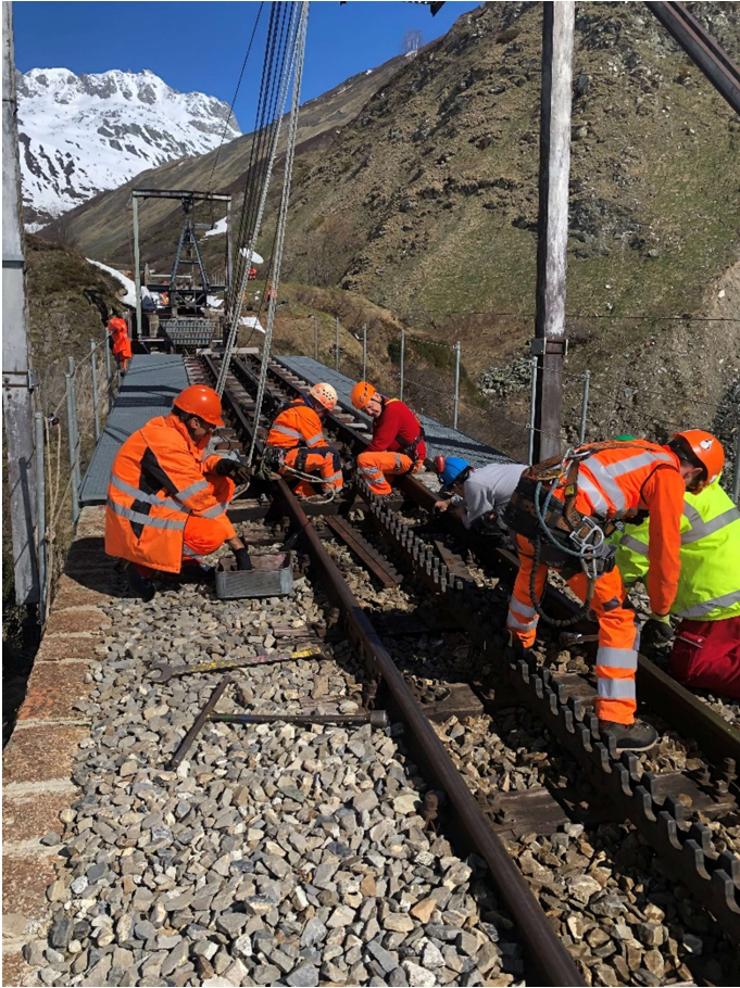
Mit vereinten Kräften wird das untere Brückenelement verlascht. Bild: Karlheinz Felder.
