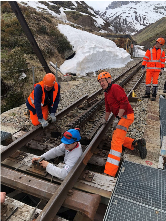
Markus Gwerder montiert die Zahnstangen am Übergang zwischen bergseitigem Widerlager und oberem Brückenelement. Bild: Karlheinz Felder.
