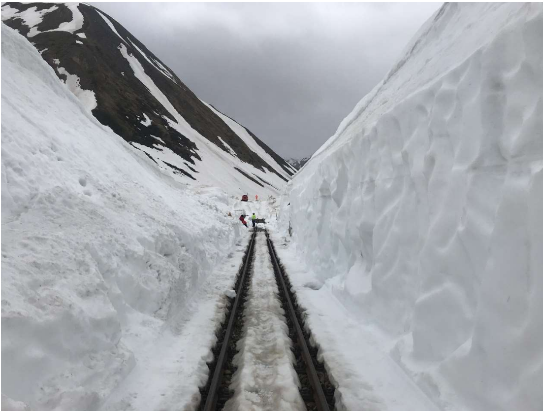
7.6.2021: Blick vom Westportal des Scheiteltunnels zur Station Muttbach-Belvédère. Bild: Luc Wullschleger.
