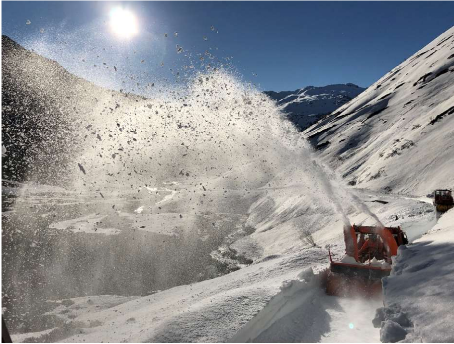
Die INTRAC Raupenfräse fräst in der Morgensonne einen zweiten Schnitt in den vereisten Schnee der Wächte kurz vor dem Steinstafelviadukt. Bild: Patrick Smit.
