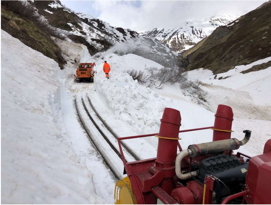
Die INTRAC Fräse beim letzten Schnitt durch den Schneerutsch zwischen Tunnel 2 und Tunnel 1. Bild: Patrick Smit
