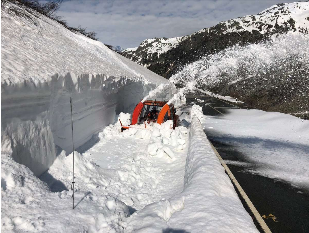
Martin Wieland beim Ausfräsen des bergseitigen Einschnitts beim Bahnübergang Furkastrasse. Die Sonderstange markiert die Position der Zahnstange hinter der Zahnstangeneinfahrt.
