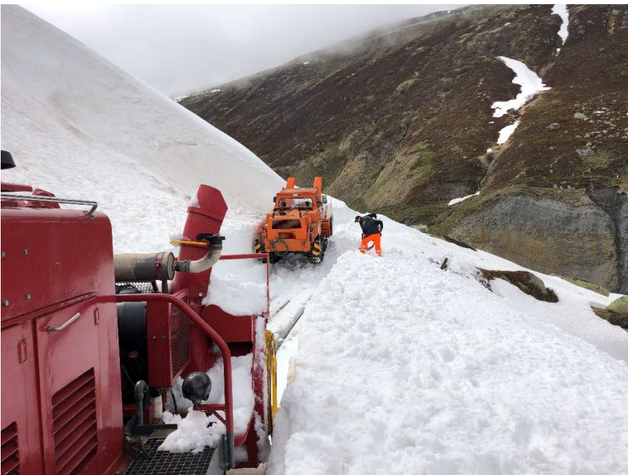
In der Steinsäumliwächte kurz vor dem Steinstafelviadukt. Bild: Patrick Smit.
