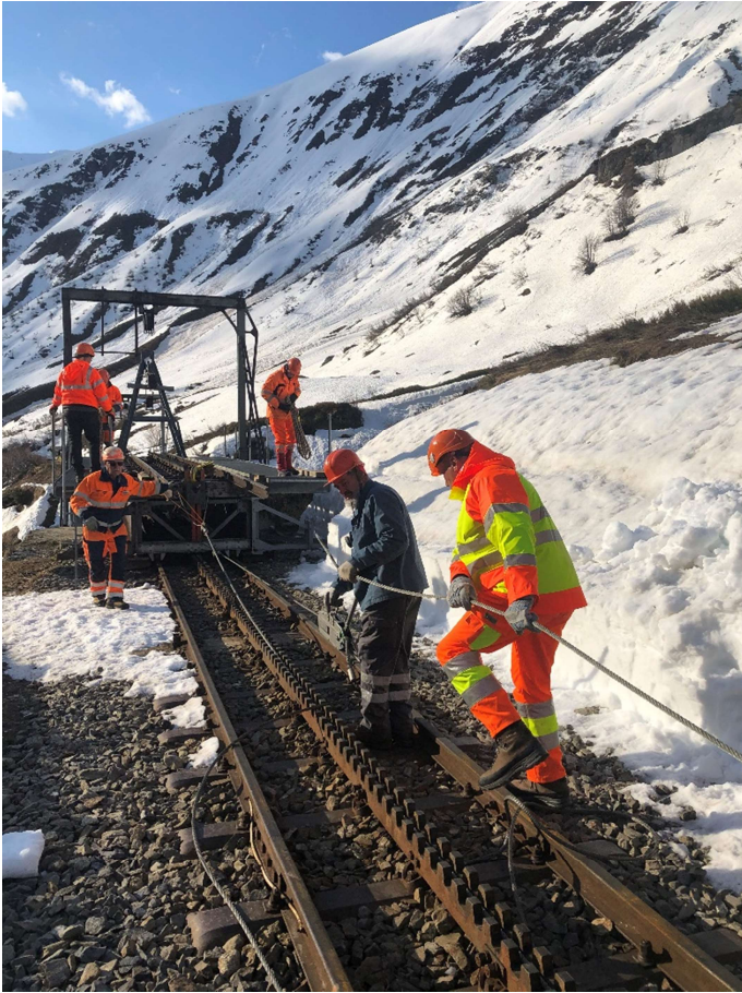
Berthi Camenzind und Beat Mühlemann ziehen das Stahlseil der unteren Winde ab. Bild: Karlheinz Felder.
