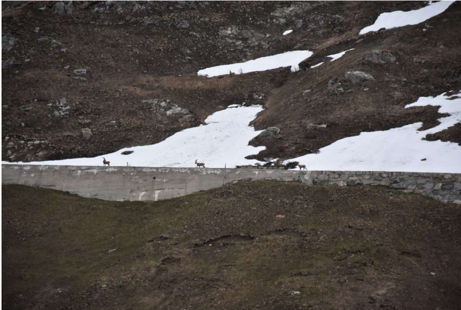
Eine Herde Steinböcke wandert auf der Furkapassstrasse Richtung Belvédère. Foto: Werner Dietrich.
