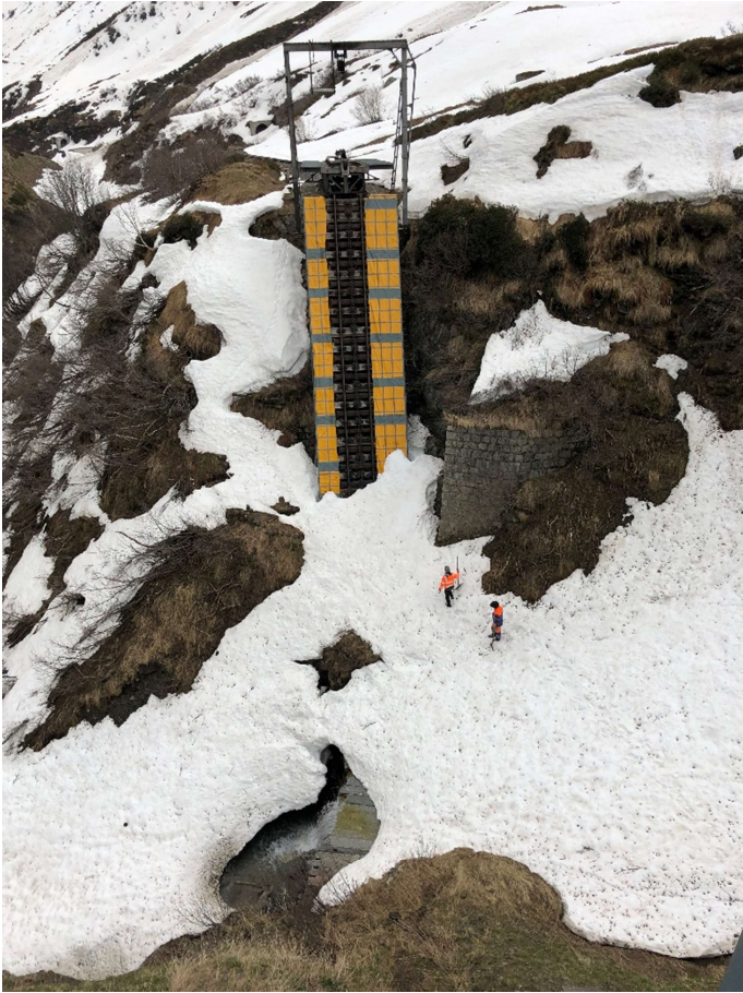
Martin Fischer, Reto Alber, Michael Bühler und Beat Mühlemann schaufeln den weichen Schnee vor der Mittelstütze der Steffenbachbrücke weg. Bild: Patrick Smit.
