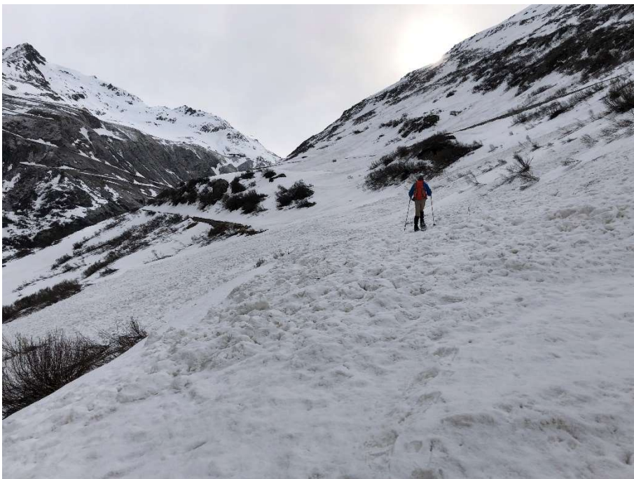
Werner Dietrich sucht sich einen Weg durch einen der vielen Lawinenkegel zwischen Gletsch und dem Bahnübergang «Furkastrasse». Die auf dem Bahntrasse bis zu 3 m mächtigen Lawinenkegel sind verharscht. Die Oberfläche ist mit einer dünnen, kürzlich gefallenen Schneeschicht bedeckt. Foto: Patrick Smit.
