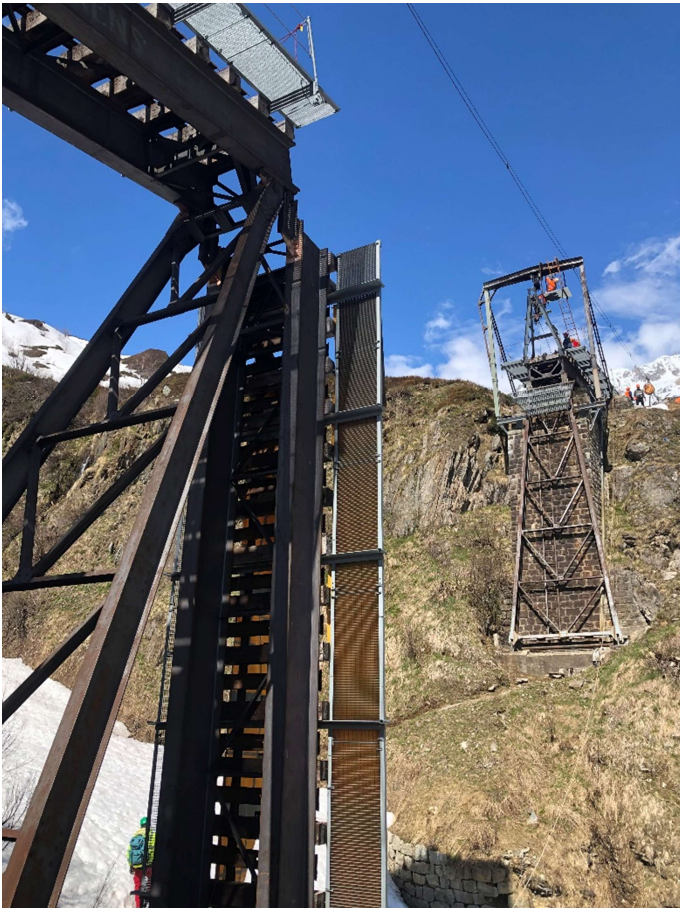
Das mittlere Brückenelement hängt am unteren Brückenelement, das bereits in der Sommerstellung ist. Bild: Karlheinz Felder.
