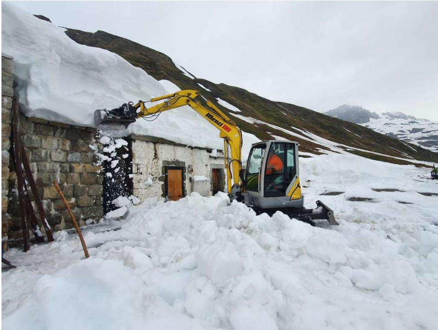
Kurt Hohl Hohl säubert das Dach und den Vorplatz des Stationsgebäudes vom Schnee.
