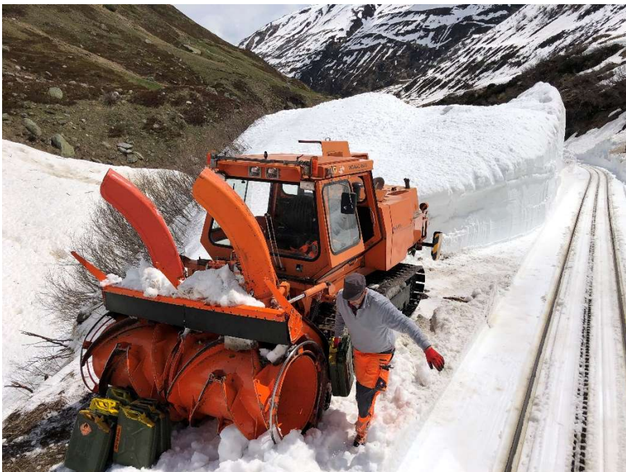
Während Thomas Holder an der INTRAC Raupenfräse Unterhaltsarbeiten durchführt, fräst die HGM 51 mit Anbaufräse das Gleis zwischen Schneerutsch und Steffenbachbrücke frei. Bild: Patrick Smit.
