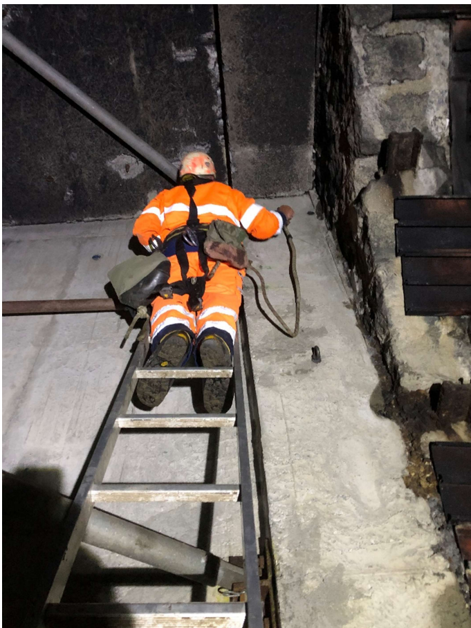
Fritz Gerber löst die die innenseitigen Verstreben der Tore des bergseitigen Portals des Tunnels 2. Bild: Karlheinz Felder.
