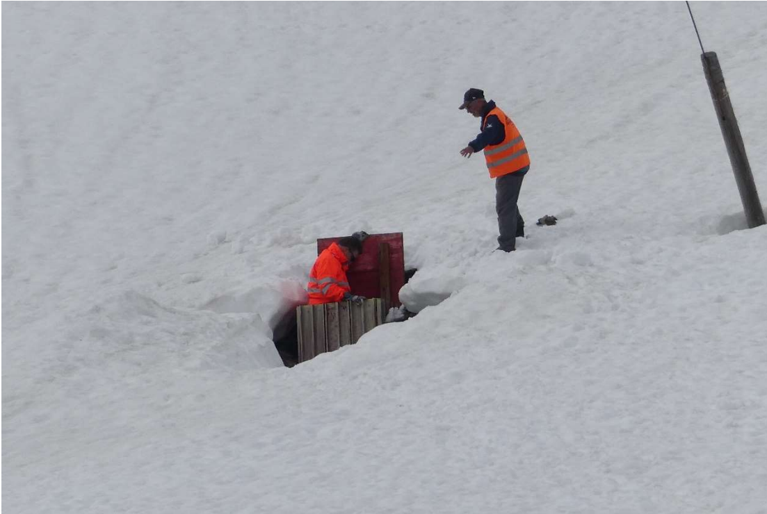
8.6.2021: Peter Fietz und Arno Rudolf wintern die Wasserfassung der Station Furka aus. Bild: Ruedi Tobler.
