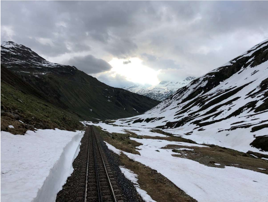
Morgenstimmung zwischen Steinstafelviadukt und Sidelenbachbrücke. Bild: Patrick Smit
