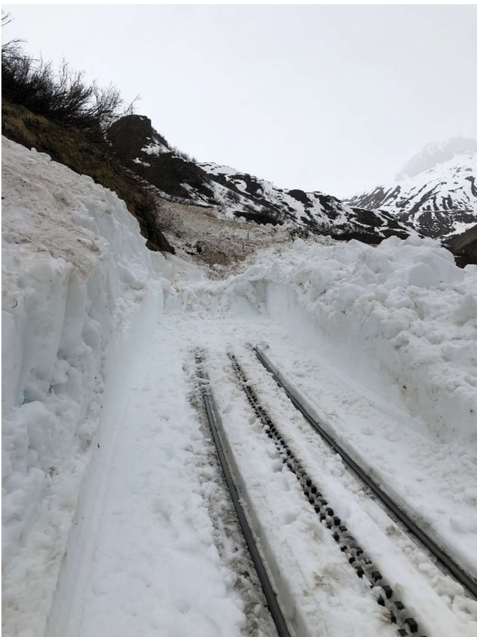
Die HGM 51 mit Anbaufräse hat das Bahntrasse bis kurz vor dem grossen Schneerutsch zwischen Tunnel 2 und Tunnel 1 geräumt. Bild: Karlheinz Felder.
