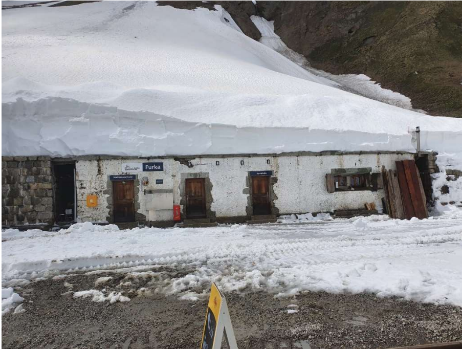
Das Dienst- und Stationsgebäude der Station Furka ist wieder offen. Bild: Michael Bühler.
