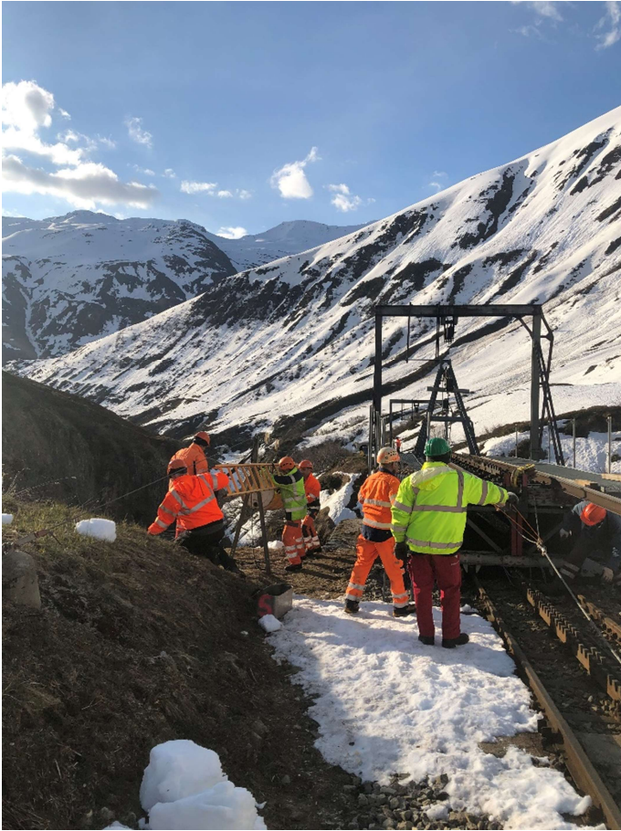
Vorbereitungsarbeiten beim bergseitigen Brückenelement. Bild: Karlheinz Felder.
