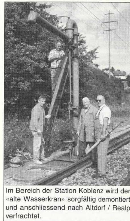
Im Bereich der Station Koblenz wird der «alte Wasserkran» sorgfältig demontiert und anschliessend nach Altdorf / Realp verfrachtet.
