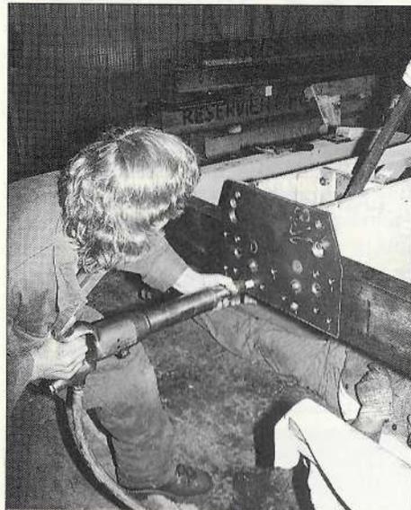
Christian Gabriel drückt mit einem speziellen Presslufthammer den rotglühenden Nietenbolzen zu einem Kopf, derweil mit einem Stemmeisen Gegendruck erzeugt wird
