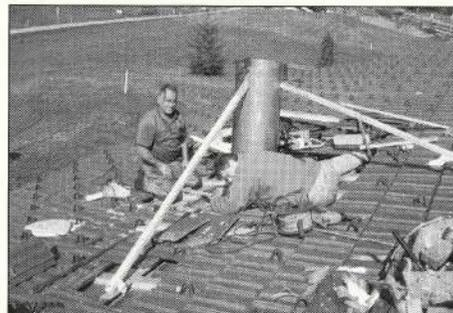
*Naef Traugott und Kurzeck Matthias in luftiger Höhe auf dem Dach des Depot Realp am 27. September 99. Umfangreiche Anpassungsarbeiten an der Dachkonstruktion im Zusammenhang mit der modifizierten Rauchabzugsanlage.*
