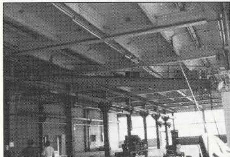
*In Schiefelage wird die Brücke des Laufkrans mit drei Habegger-Seilzügen auf den sicheren Boden abgesenkt.*
