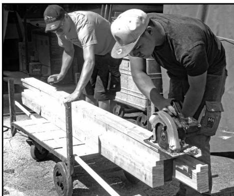
*Masshobeln der Bodenbalken und fälzen für die Aufnahme der Bodenplatten*
