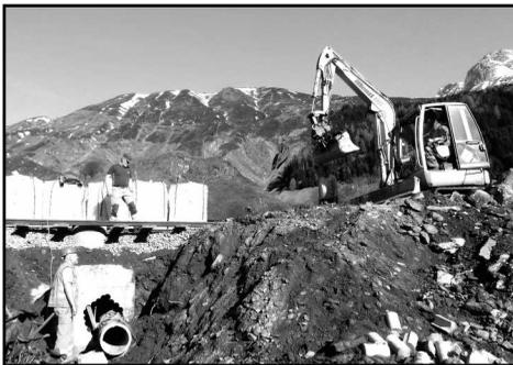
*Herausbohren des Entwässerungsrohres aus dem alten Schacht*
