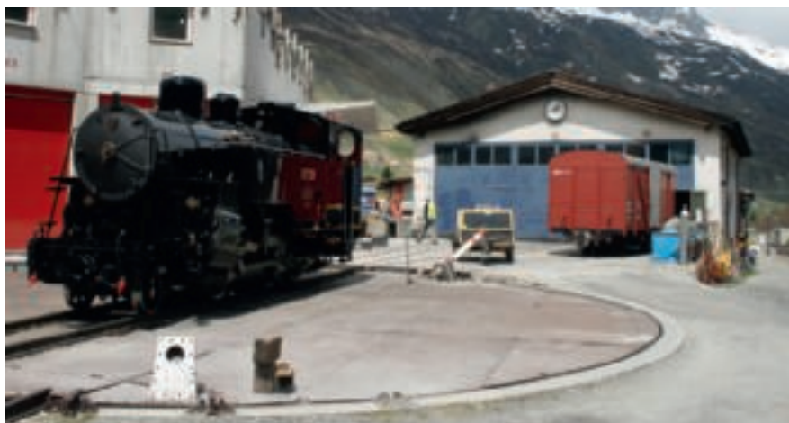
Auf der Drehscheibe vor der neu errichteten DFB-Werkstätte
