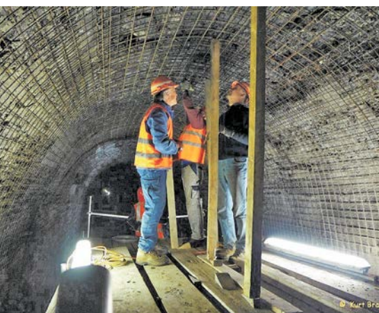
Anlegen der Absturzsicherung
