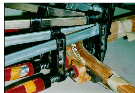
Instandsetzung der Fensterrahmen
