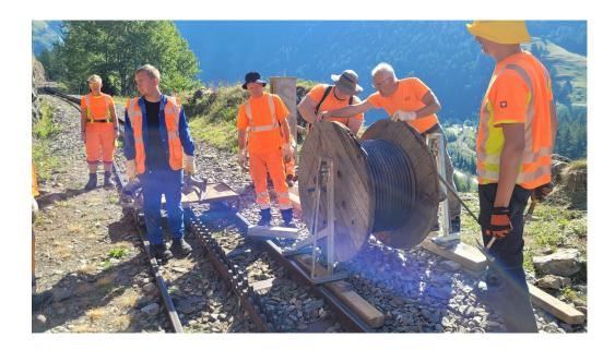
Die folgende Baustelle war dann ein echtes Abenteuer. In der Rottenschlucht, oberhalb der Rottenbrücke, sollte eine neue Wasserleitung lawinen- und steinschlagsicher verlegt werden – in extrem herausforderndem Gelände.
