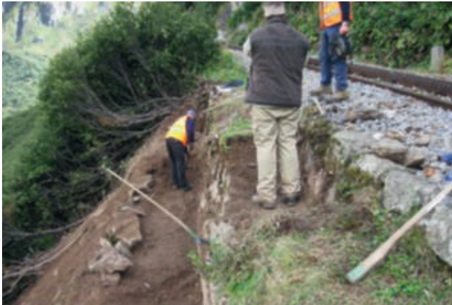
Arbeiten zum Freilegen der Stützmauer bei km 47,6 / Travaux de dégagement du mur de soutènement au PK 47,6t
