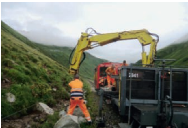
Verladung von Felsen mittels Kranwagen und Tmh 985 / Chargement de rocs avec le wagon-grue et le Tmh 985
