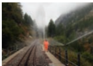
Sprinkleranlage vor der Einwinterung / Installation d'arrosage avant l'hivernage
