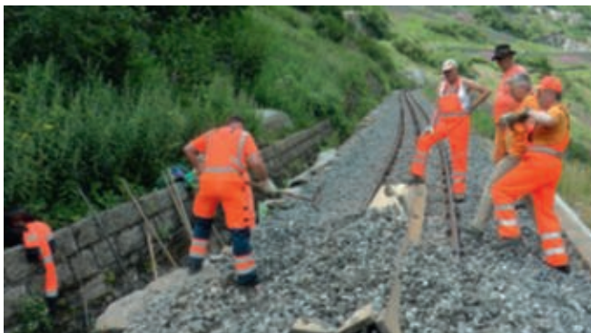
Arbeiten mit dem «Chinesenbagger» zwecks Sanierung des Wassergrabens / Travaux avec l'excavatrice chinoise
