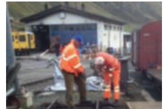
Gleisjochdemontage vor dem Depot / Démontage de coupons de voie devant le dépôt
