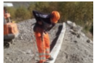
Bohren für die Stahldornen / Forage pour les tiges en acier
