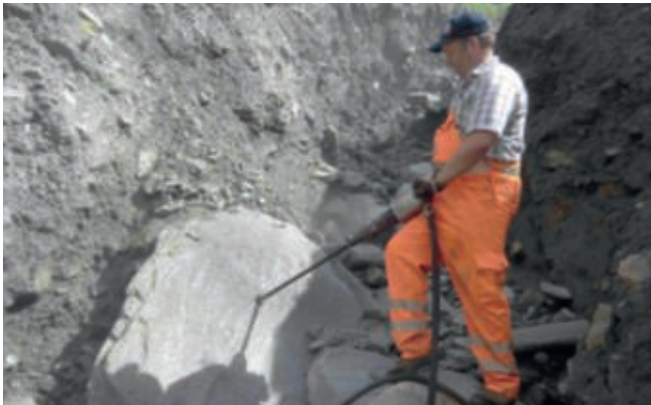
Vorbereitung der Sprengung durch unseren Profi Jens Dreyer / Préparation du dynamitage par notre pro Jens Dreyer
