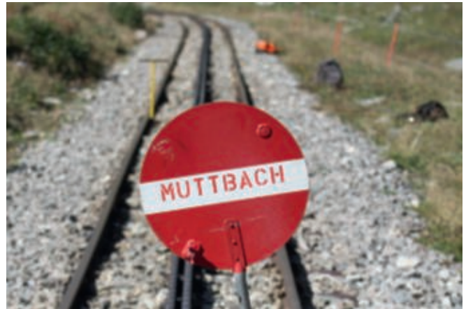
Gesicherte Gleisbaustelle für eine unfallfreie Arbeit / Chantier ferroviaire sécurisé
