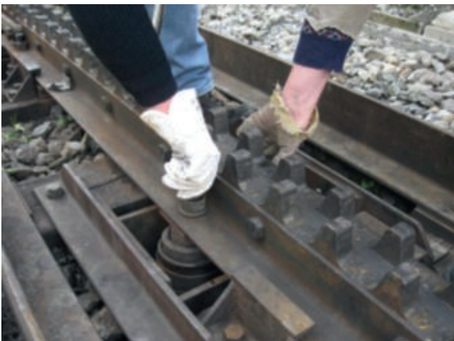
Höheneinstellung der Zahnstangeneinfahrten / Réglage de la hauteur de l'entrée de la crémaillère
