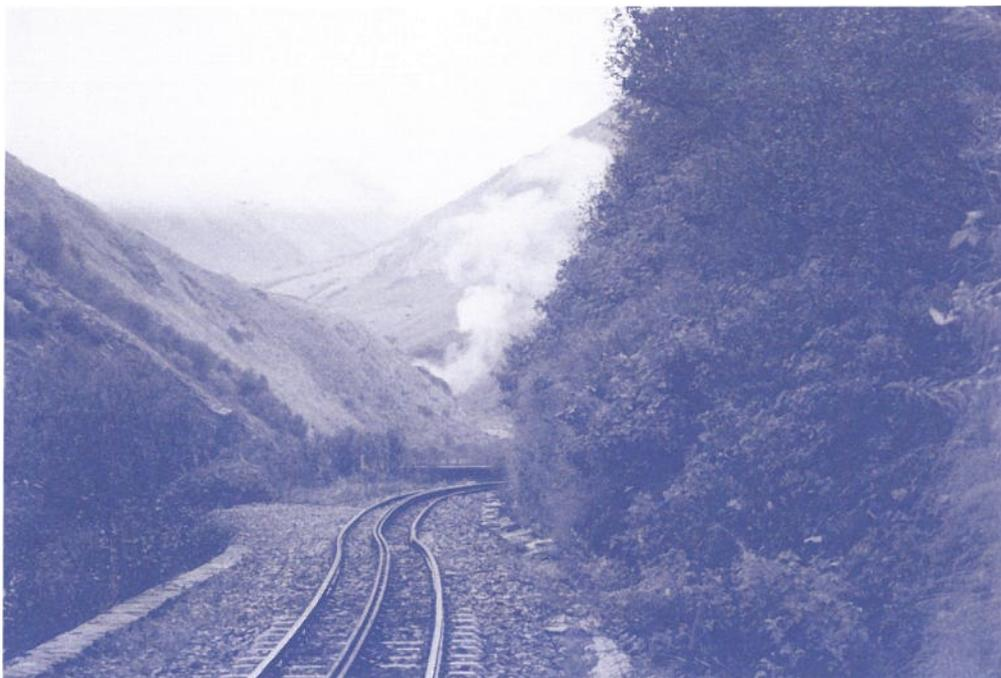
Gut erkennbar in der Bildmitte: Gleisverschiebung bei km 57.500 (oberhalb Realp). Die Gleislage wurde um rund 30 cm verschoben.
