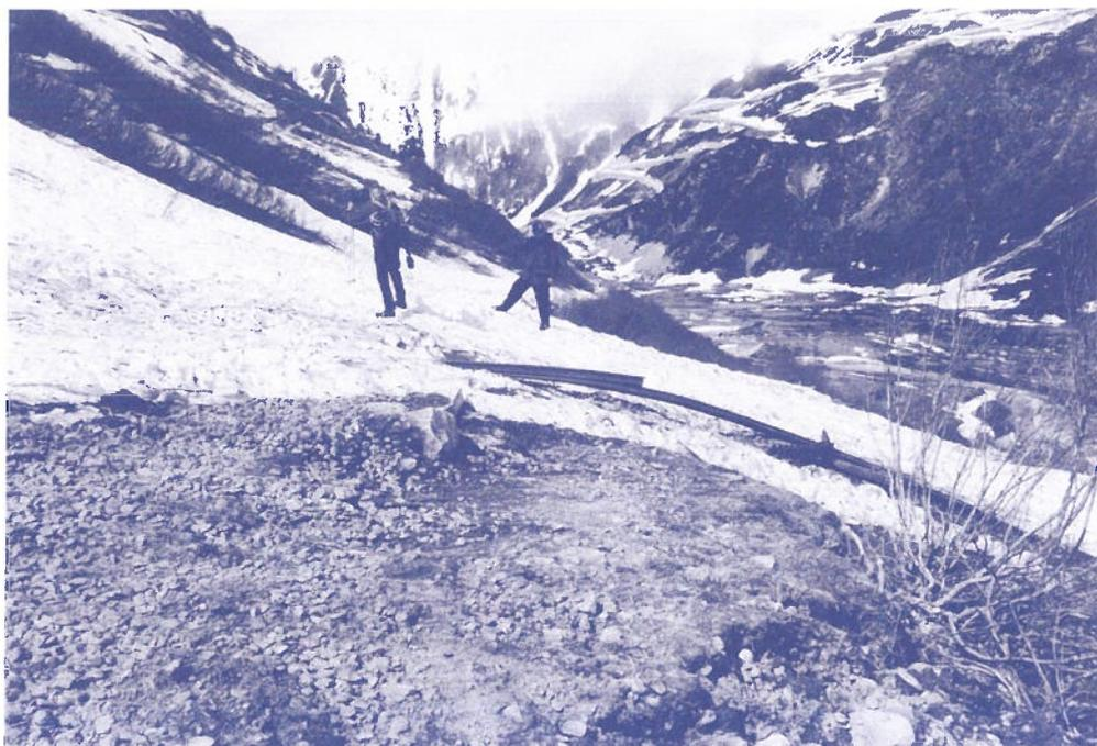
Zwischen Gletsch und Muttbach, wurde das Gleis bei km 46.500 durch eine Lawine völlig zerstört und mitgerissen.
