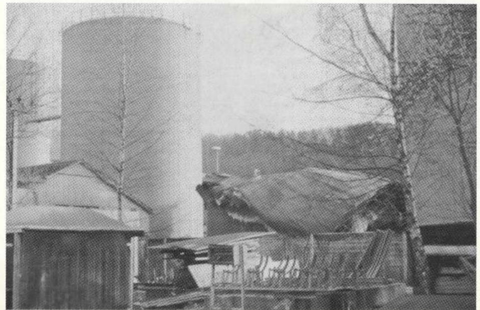
Das Tanklager mit unserer Werkstatthalte in unmittelbarer Nähe
