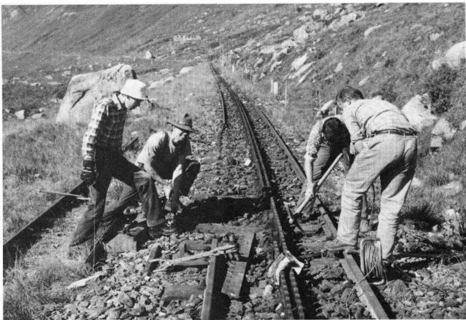
Gleisbau oberhalb der Steinstafelbrücke am 8. September 1988
