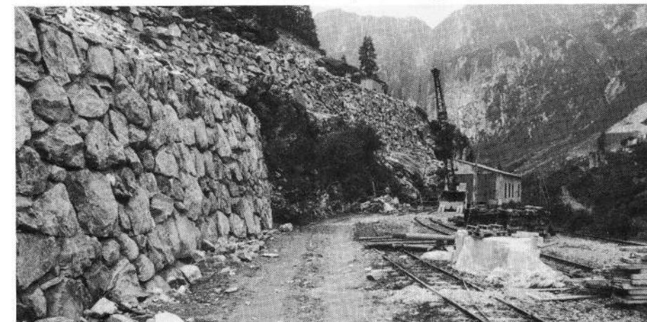
Entlang des Areals in Gletsch ist eine Stützmauer erstellt worden
