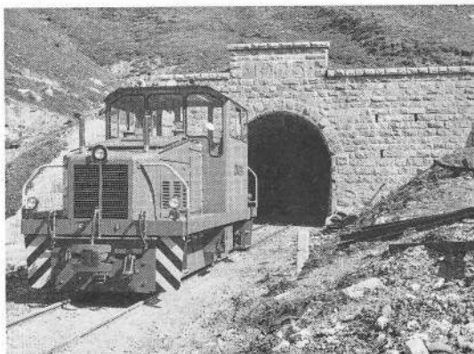
Diesellok HGM 2/2 vor Portal Scheiteltunnel, Seite Wallis, am 17. September 1988
