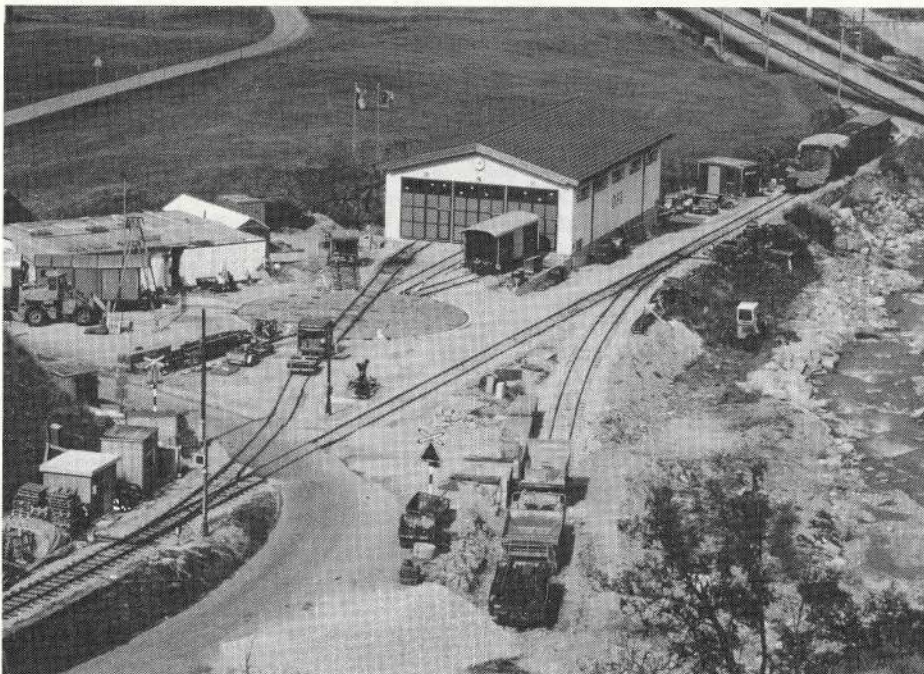
Der Installationsplatz Realp mit dem BUe «Schweigstrasse» (Sommer 1991).
