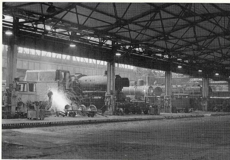
Blick in die Lokrichthalle (Foto: H. Riedel)
