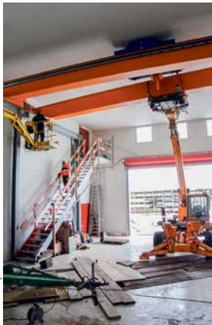
Montage des Hauptträgers des 16-Tonnen-Hallenkrans im Werkstattgebäude
